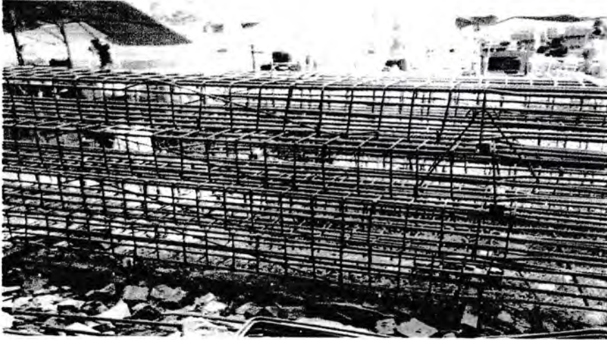
Gambar 3.17 Pekerjaan pemotongan dan pembengkokan tulangan
