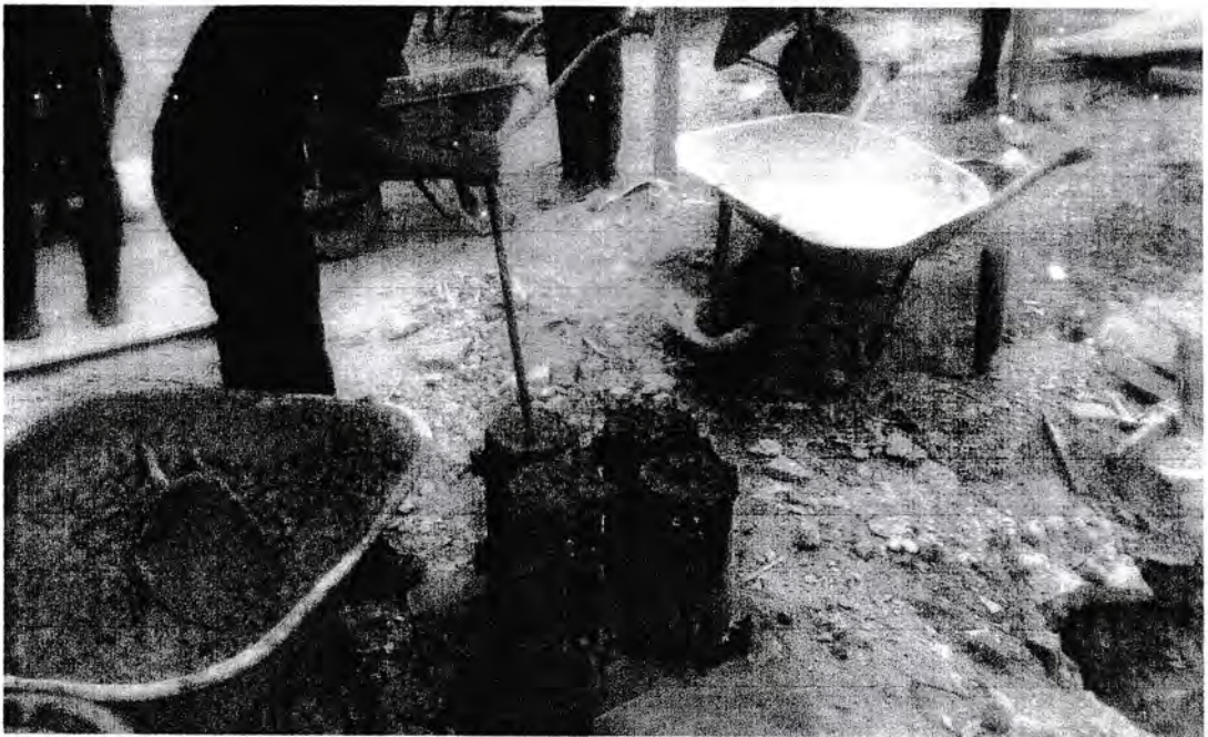
Gambar.Pengujian Beton Lokasi : Jl. S.parman
