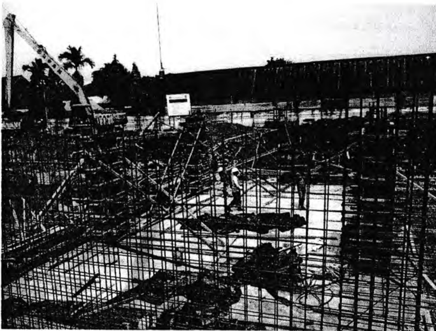
Gambar. Proses Pengeringan Kolom
