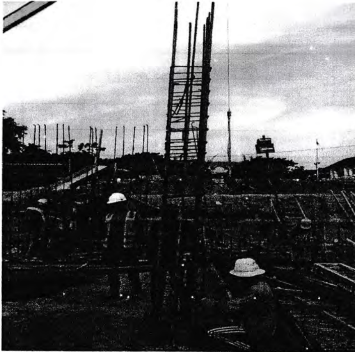
Gambar. Making Kolom dengan Lokasi
