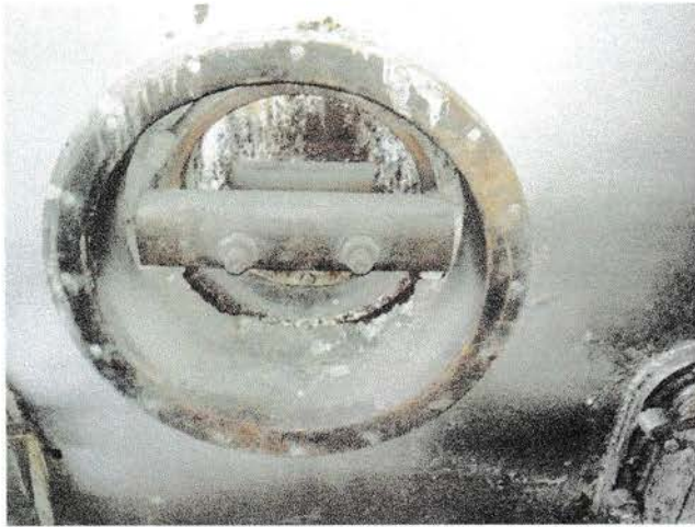
Gambar 4.2.1.c. Drum Bawah
