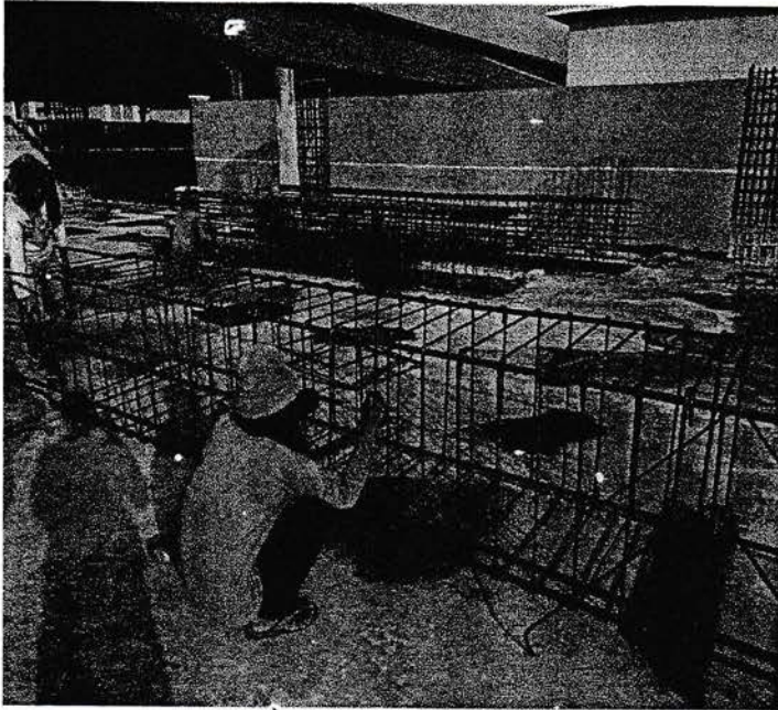
Pekerjaan Pengikatan Tulangan Kolom
