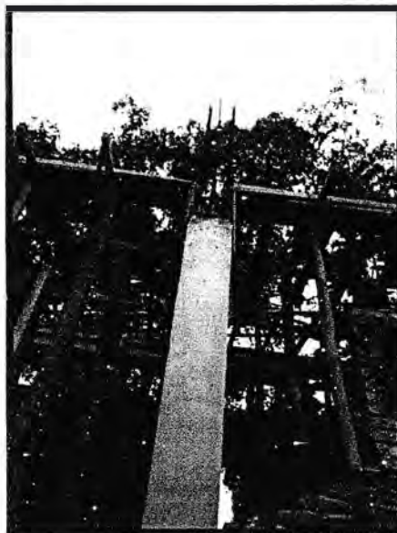
III. 10 pengerjaan sambungan kolom dengan Balok
