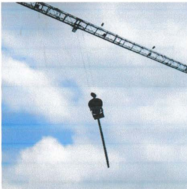
Gambar 4.1.5 Pengangkatan Bucket cor
