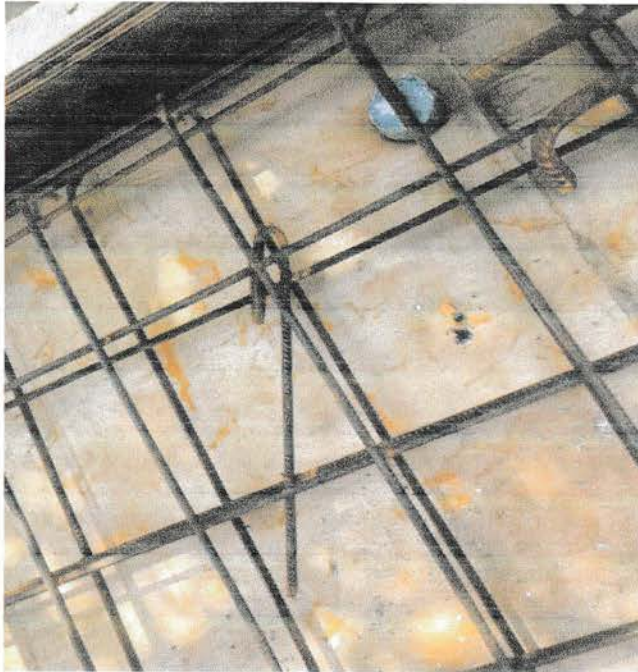
Gambar 4.1.9.3 Pemasangan dudukkan pada tulangan
