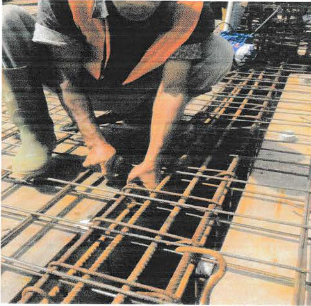
Gambar 4.1.9.1 Pemasangan kawat ikat pada tulangan.
