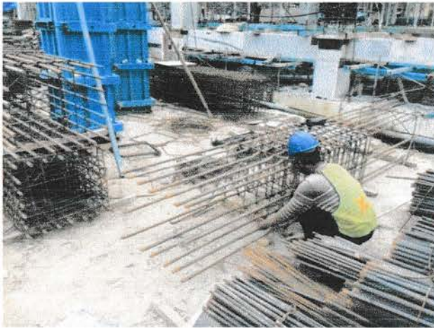
Gambar 4.1.3.1 Pekerjaan perakitan tulangan kolom
