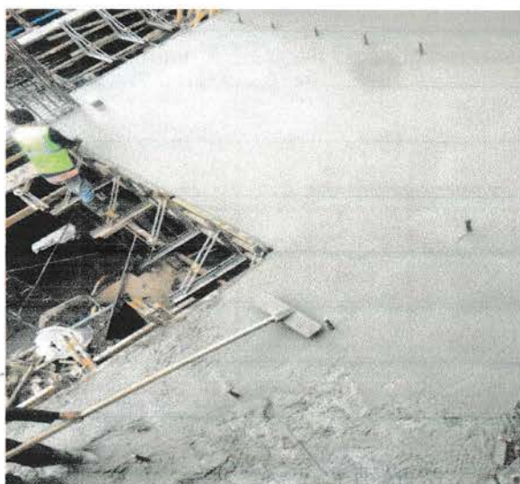
Gambar 4.1.10.3 Perataan beton menggunakan papan penekan
