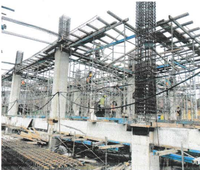
Gambar 4.7 Pemasangan Scaffolding
