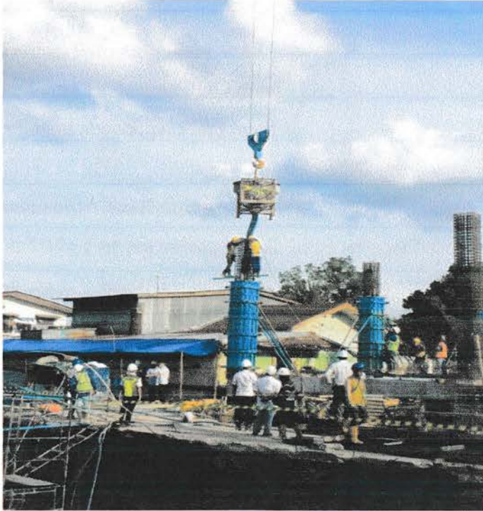
Gambar 4.1.5.1 Pengecoran Kolom yang berlangsung
