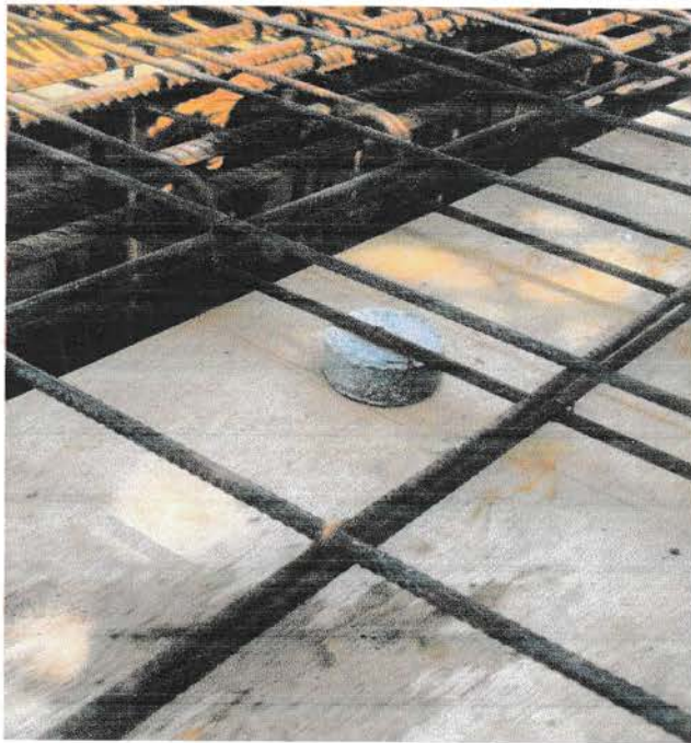
Gambar 4.1.9.2 Peletakan beton decking pada penulangan plat.
