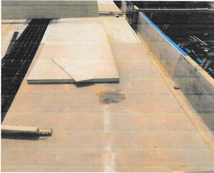
Gambar 4.1.8 Bekisting Plat Lantai
