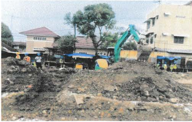
Gambar 4.1.1 Gambar Penggalian tanah Gedung Service
