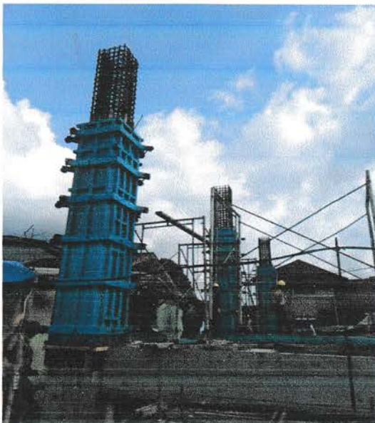
Gambar 4.1.4.1 Bekisting Terpasang
