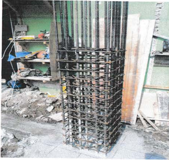
Gambar 4.1.3.2 Pemasangan penulangan kolom yang sudah dirakit
