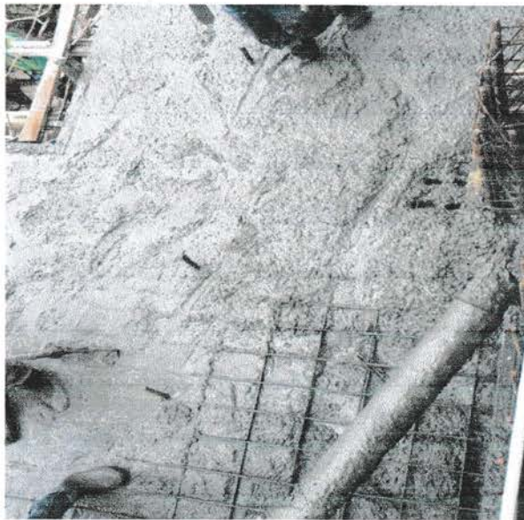
Gambar 4.1.10.1 Pengecoran plat lantai berlangsung
