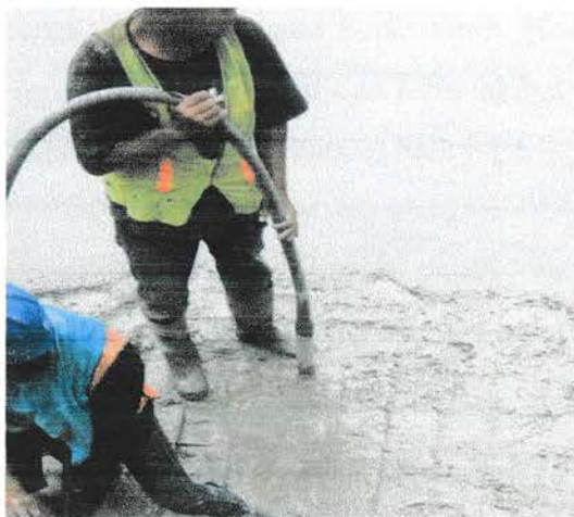
Gambar 4.1.10.2 Pemadatan beton menggunakan alat vibrator
