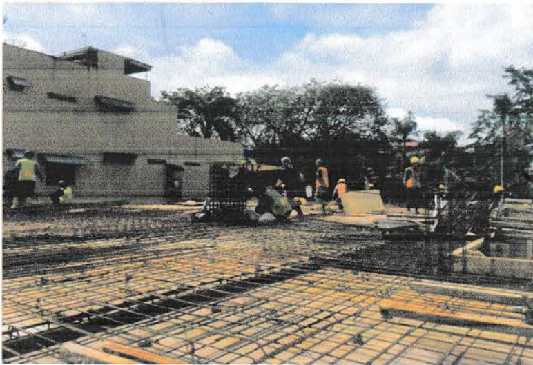
Gambar 4.1.9.4 Pekerjaan pemasangan tulangan plat lantai
