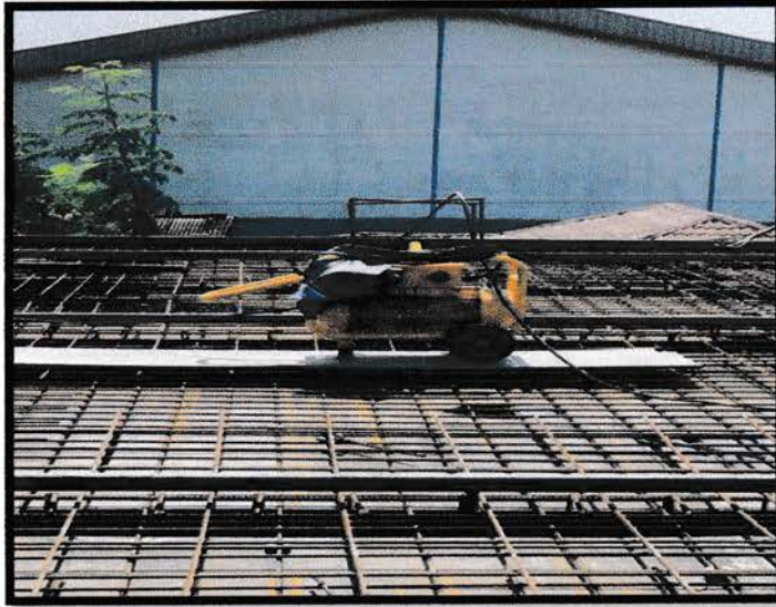
Gambar 4.3 Vibrator Sumber: (Data Lapangan)
