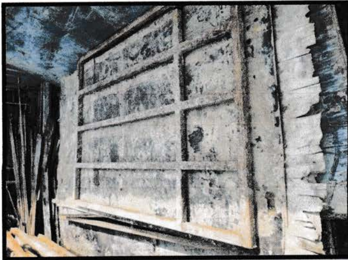
Gambar 4.7 Cetakan ( Bekisting ) Sumber: (Data Lapangan)
