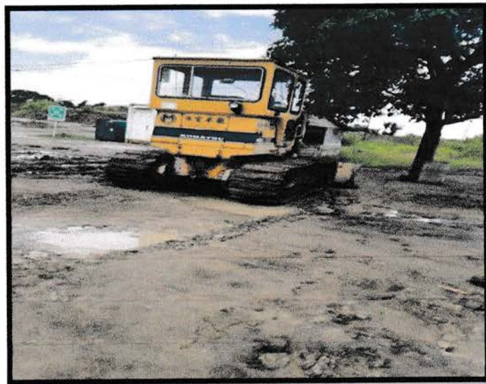
Gambar 4.12 Mesin Penggilas ( Bulldozer ) Sumber: (Data Lapangan)
