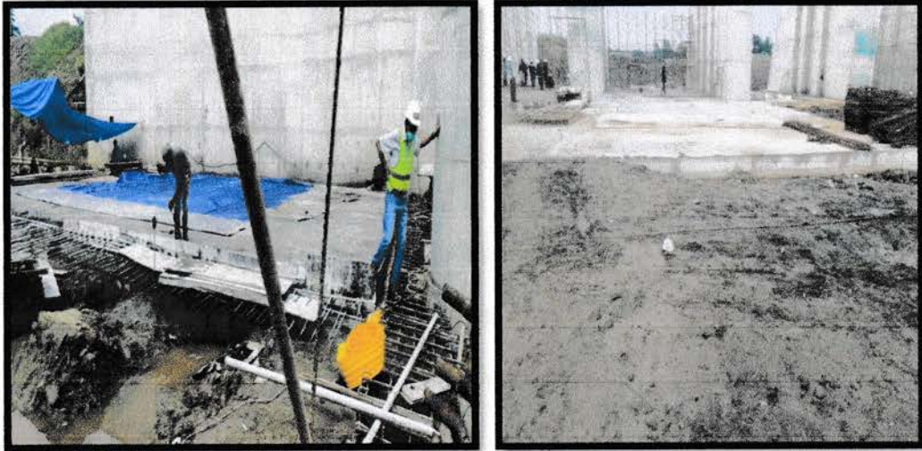
Gambar 4.25 Pembongkaran Bekisting Apron Sumber: (Data Lapangan)
