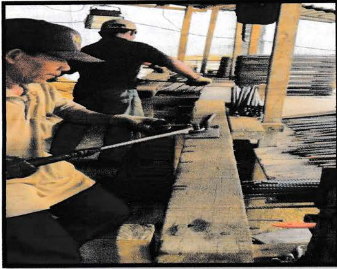
Gambar 4.6 Pembengkok Besi ( Bar Bending ) Sumber: Data Lapangan
