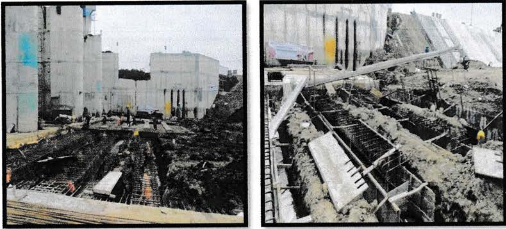
Gambar 4.22 Pemasangan Tulangan Apron dan Bekisting Apron Sumber: (Data Lapangan)
