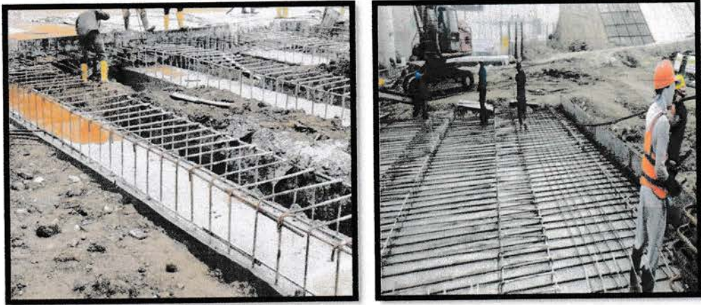
Gambar 4.23 Pengecoran Balok dan Pemasangan Tulangan Apron Sumber: (Data Lapangan)
