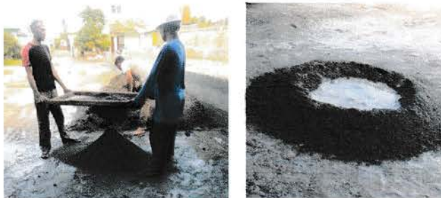
Gambar 1. Pekerjaan Adukan Semen
