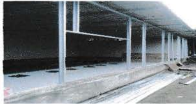
Gambar 4. Rangka Baja Ringan untuk Pemasangan Dinding
