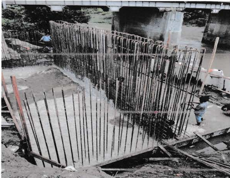
Gambar 3.1 Pembesian Dinding Abutment Segmen Pertama
