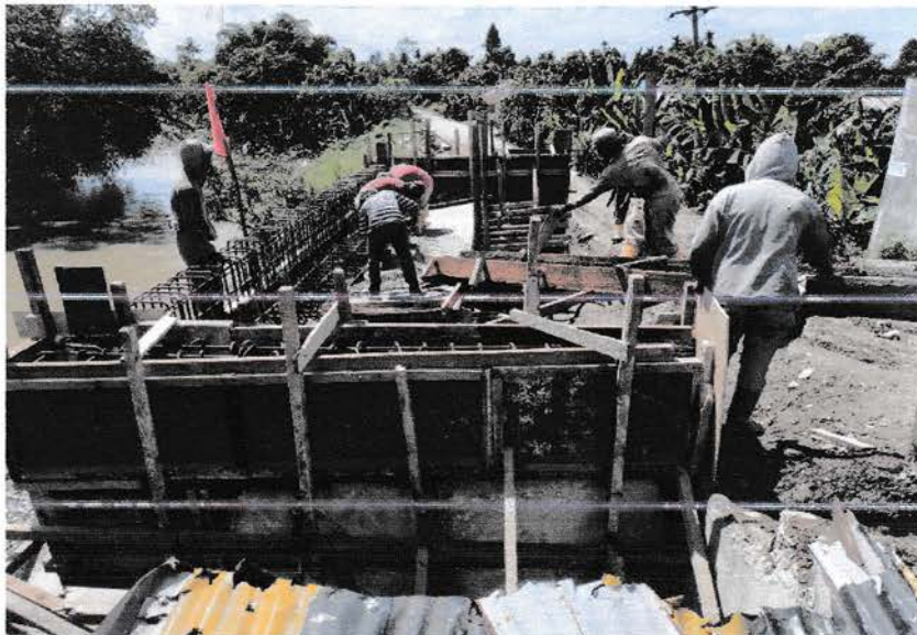
Gambar 3.8 Proses pengecoran Segmen Kedua
