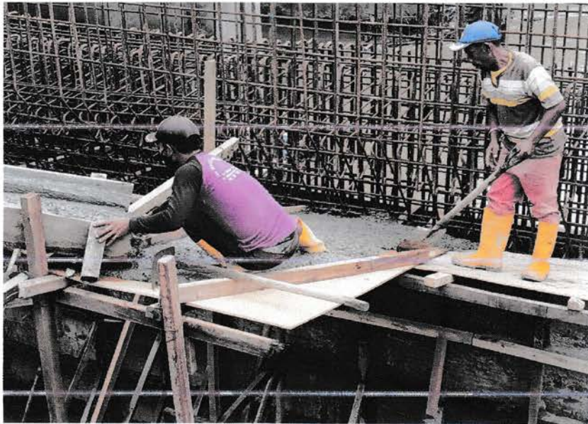
Gambar 3.7 Proses Pengecoran Segmen Pertama
