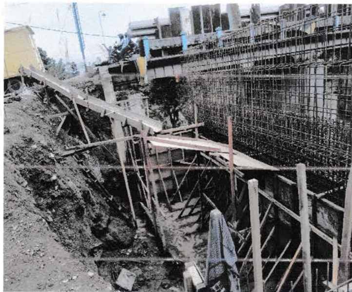
Gambar 3.4 Pemasangan Bekisting dan Saluran Untuk Pengecoran Segmen Pertama
