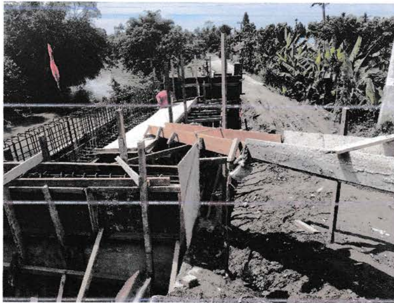
Gambar 3.6 pemasangan Bekisting dan Saluran Pengecoran segmen kedua
