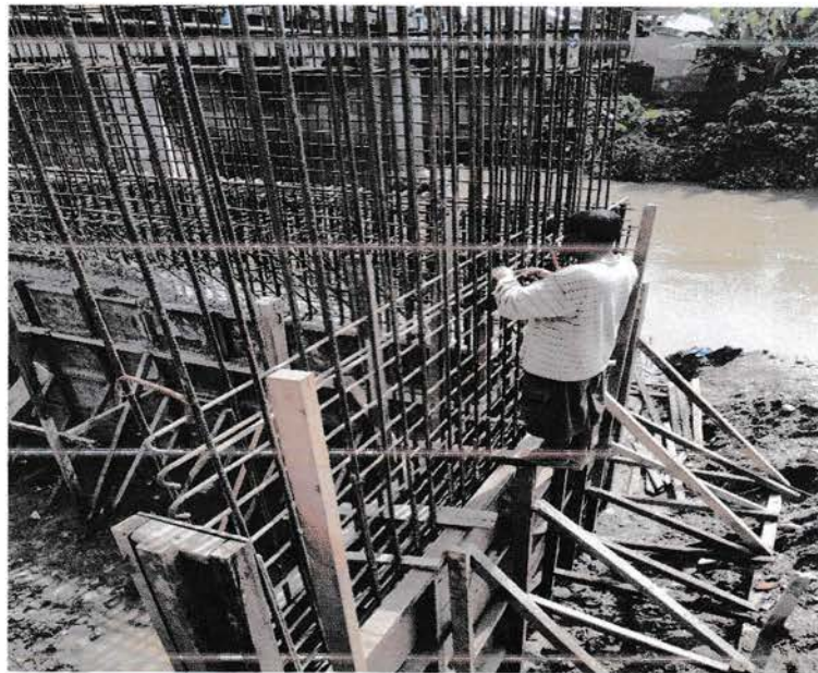
Gambar 3.2 Pembesian Dinding Abutment Segmen Kedua
