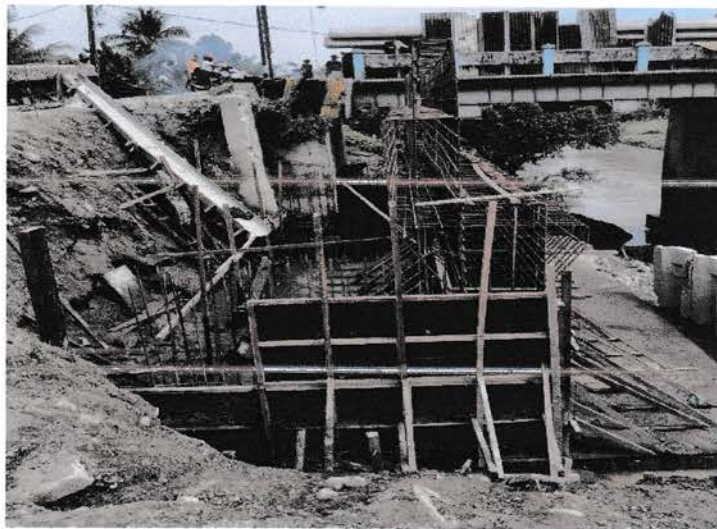
Gambar 3.3 Pemasangan Bekisting Segmen Pertama
