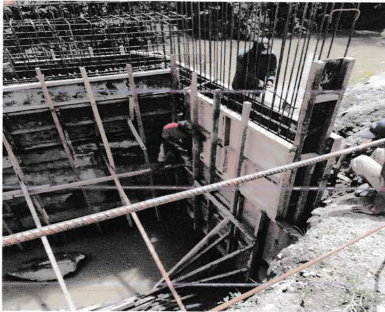
Gambar 3.5 pemasangan Bekisting Segmen kedua
