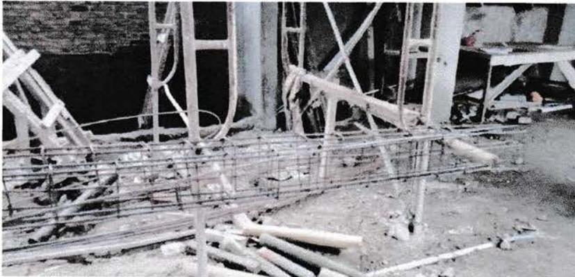
Gambar 1. Pembuatan beugel / sengkang
