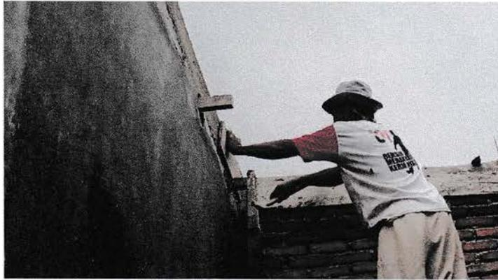
Gambar 3. Pemasangan bekisting
