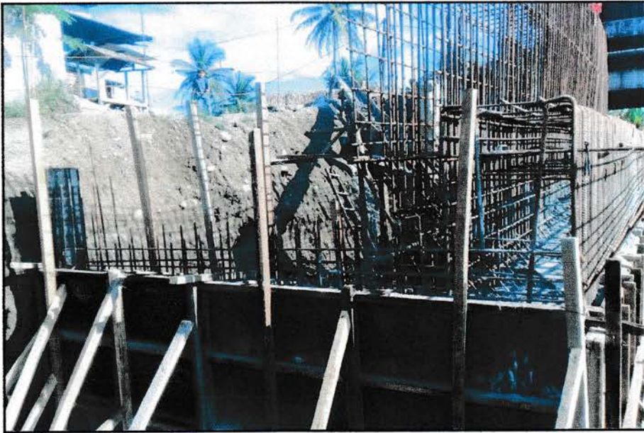
Gambar 3.1. Pembesian Dinding Penahan Tanah Sumber : Dokumentasi Pribadi
