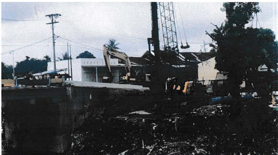
Gambar 3.12. Balok Diafragma yang sedang disiapkan Sumber : Dokumentasi Pribadi
