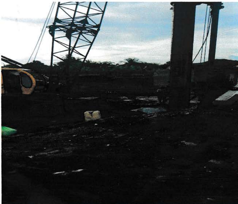
Gambar 3.15. Mobil Crane Sumber : Dokumentasi Pribadi
