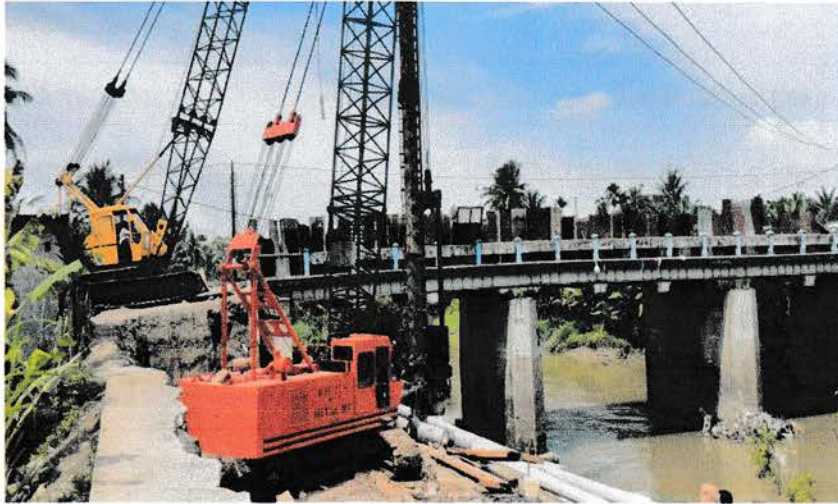
Gambar 3.11. Pemasangan Girder menggunakan crane Sumber : Dokumentasi Pribadi
