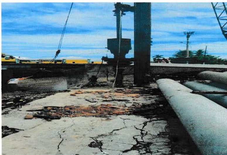
Gambar 3.17. Bore Pile Mini Crane sedang beroperasi Sumber : Dokumentasi Pribadi
