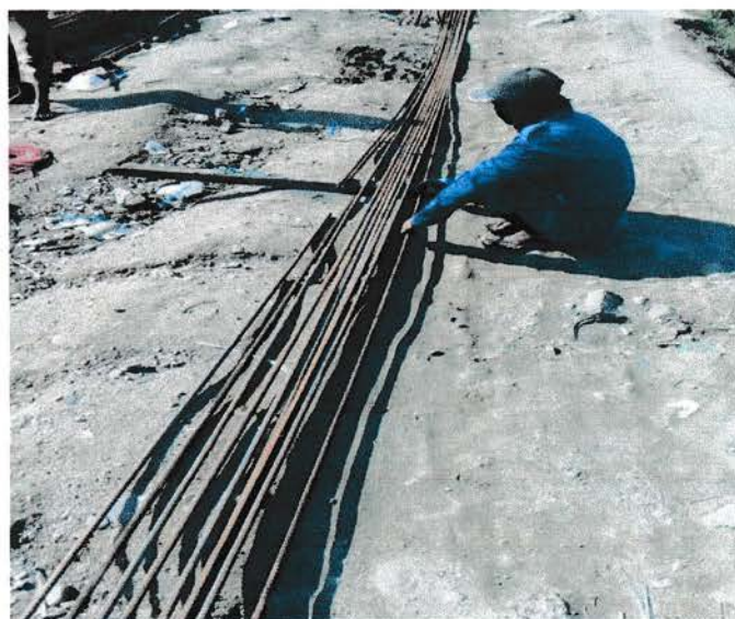
Gambar 3.7. Pekerjaan Kepala Pilar Sumber : Dokumentasi Pribadi
