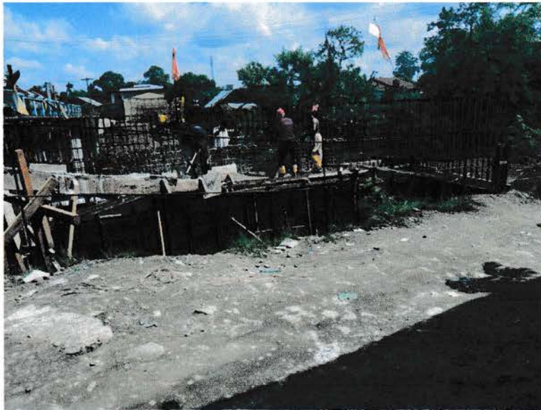
Gambar 3.8. Pemasangan strand Sumber : Dokumentasi Pribadi
