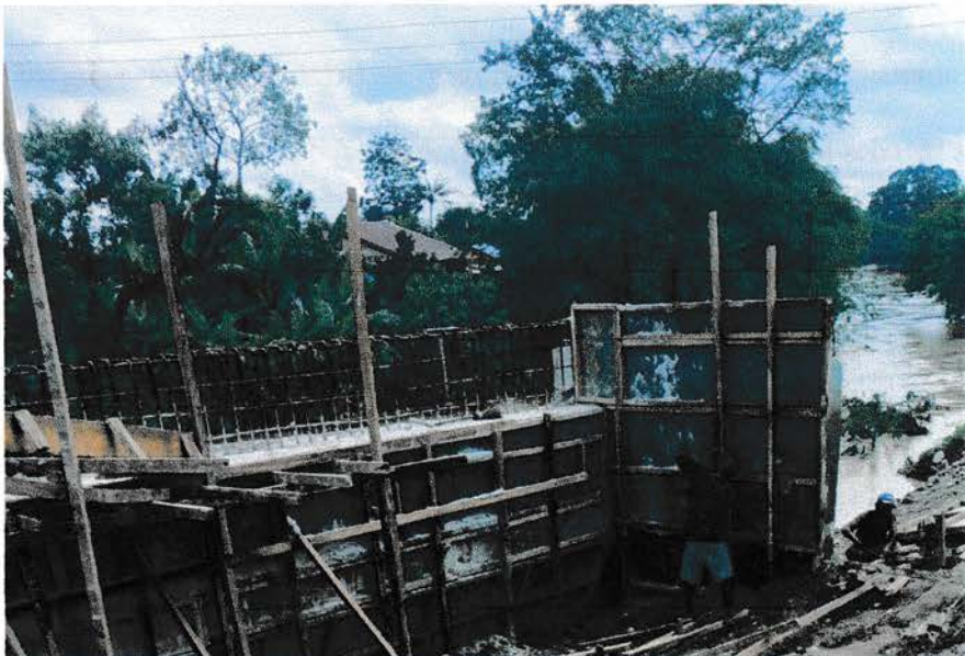
Gambar 3.13. Pekerjaan Deck Plat Sumber : Dokumentasi Pribadi
