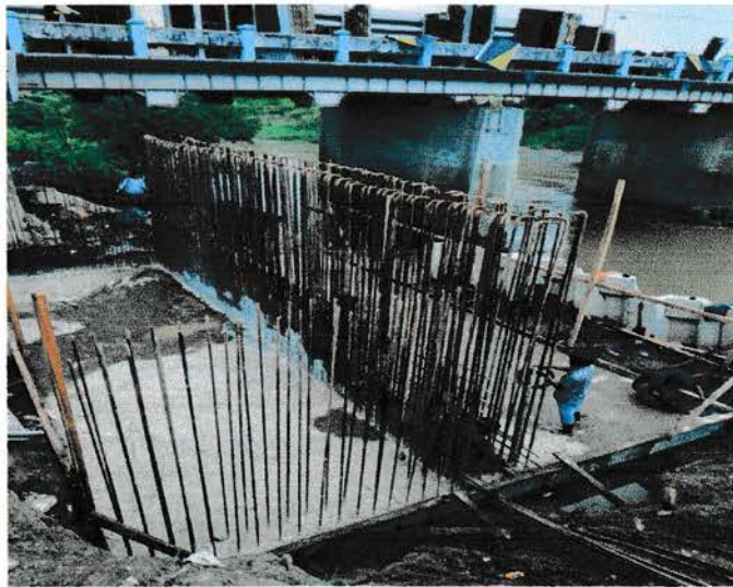
Gambar 3.6. Bekisting Badan Pilar Sumber : Dokumentasi Pribadi
