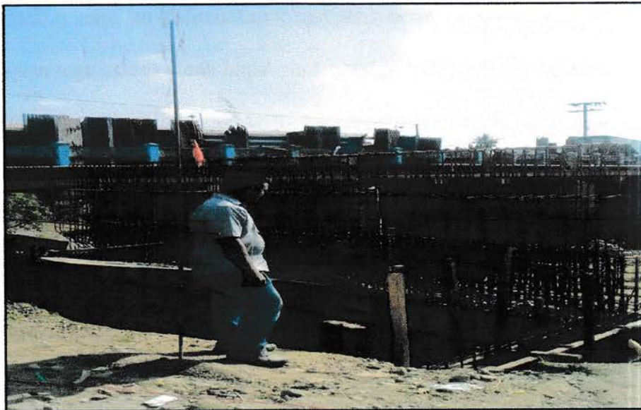
Gambar 3.2. Pembesian Dinding Penahan Tanah Sumber : Dokumentasi Pribadi
