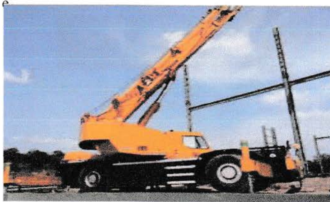
Gambar 4.12 Pemasangan Kolom Baja WF Sumber : data lapangan
