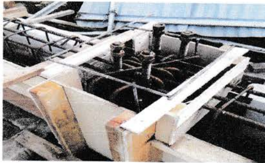
Gambar 4.8 Angkur setelah dipasang Sumber : data lapangan
