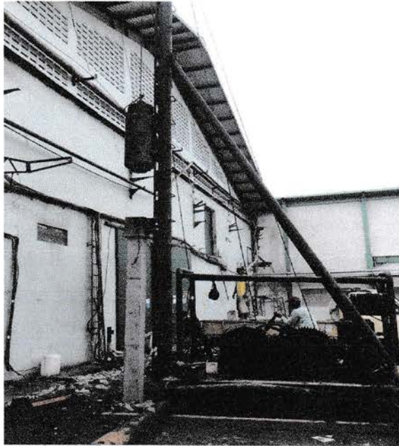
Gambar 3.3 Drop Hammer Sumber : data lapangan
