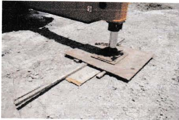
Gambar 4.11 Proses Jacking Pada Mobile Crane Sumber : data lapangan
