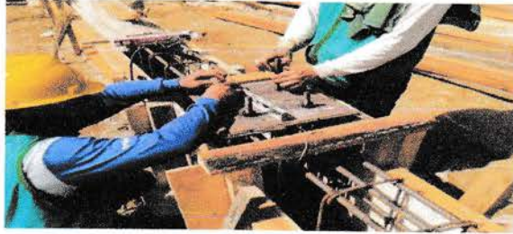
Gambar 4.7 Pemasangan Stop Cor dan Pengikat Angkur Sumber : data lapangan
