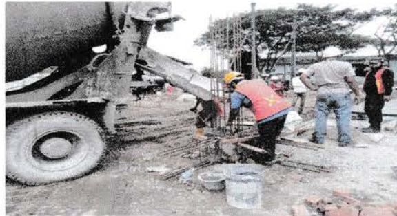
Gambar 3.15 beton ready mix Sumber : data lapangan
