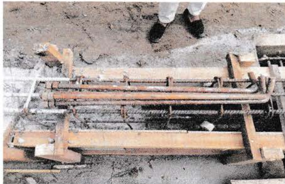
Gambar 3.21 Besi Angkur Sumber : data lapangan
