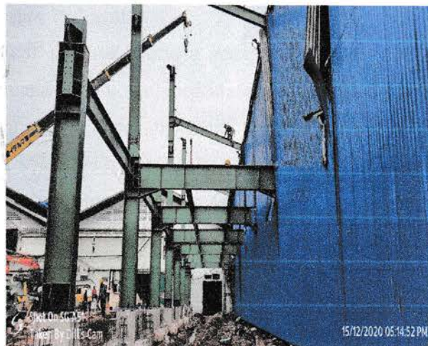
Gambar 4.1 Kolom Baja Sumber: data Lapangan
