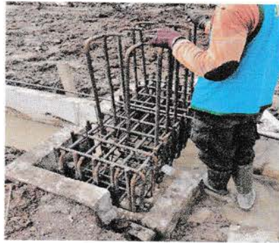
Gambar 4.4 Pengikatan Tulangan Utama Dengan Kawat Beton Sumber : data lapangan
