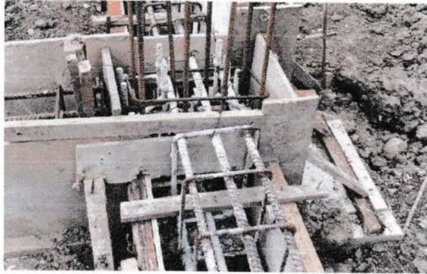
Gambar 4.5 Bekisting Kolom Pedestal Sumber : data lapangan
