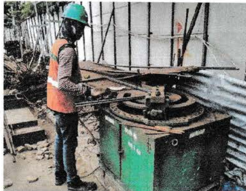
Gambar 4.3 Pabrikasi Kolom Pedestal Sumber : data lapangan
