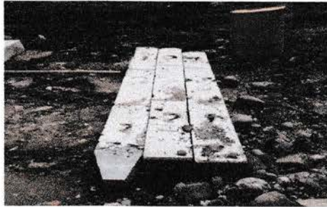
Gambar 3.11 Tiang Pancang Sumber : data lapangan
