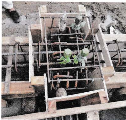
Gambar 4.9 Pembungkusan Mur Angkur Sumber : data lapangan
