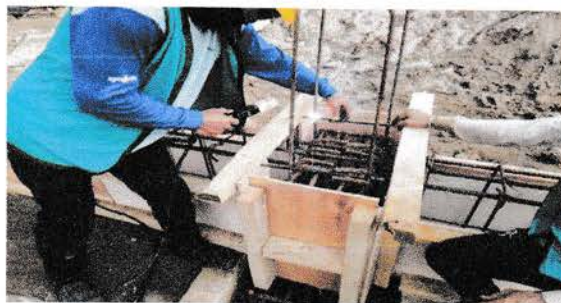
Gambar 4.6 Pemasangan Stop Cor dan Pengikat Angkur Sumber : data lapangan
