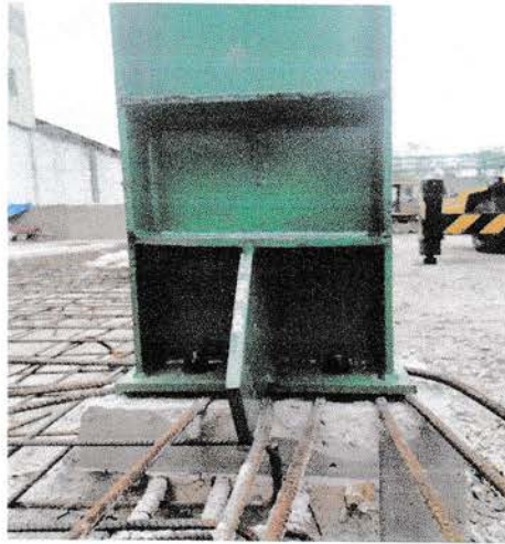
Gambar 4.13 Kolom Baja yang Telah dikunci Sumber : data lapangan
