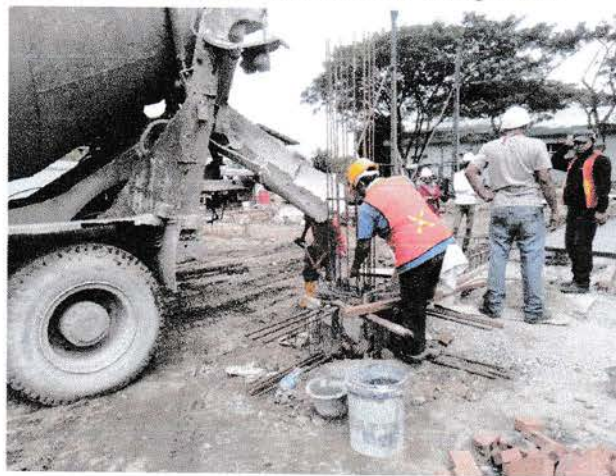
Gambar 4.10 Pengecoran Kolom Pedestal Sumber : data lapangan
