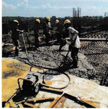
Gambar 4.61 Proses Pengecoran
