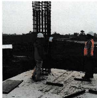
Gambar 4.35 Proses Pengecekan Tulangan
