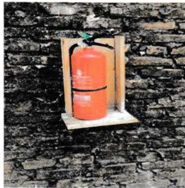
Gambar 4.79 Tabung Pemadam Kebakaran
