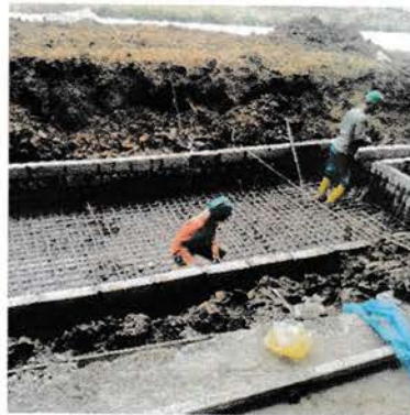
Gambar 4.24 Proses Penulangan Pile Cap
