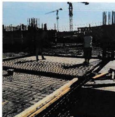
Gambar 4.56 Pemasangan Wiremesh Bawah
