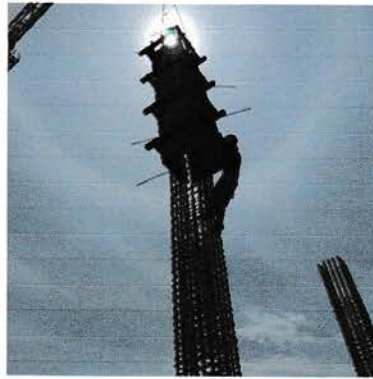
Gambar 4.38 Proses Pemasangan Bekisting
