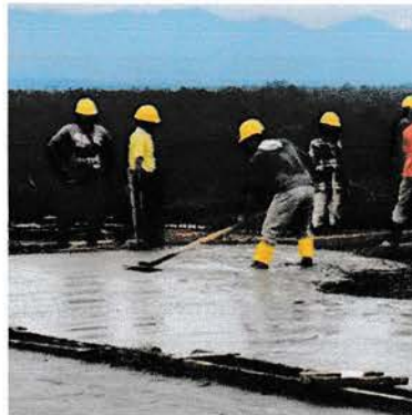
Gambar 4.62 Proses Pemerataan Cairan Beton
