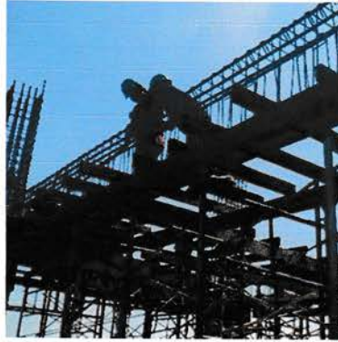
Gambar 4.51 Pemasangan Sengkang
