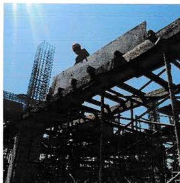
Gambar 4.48 Pemasangan Bekisting
