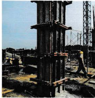
Gambar 4.45 Pembongkaran Bekisting
