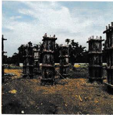
Gambar 4.36 Bekisting Kolom yang Sudah Dirakit
