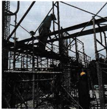
Gambar 4.47 Pemasangan Balok Gilder
