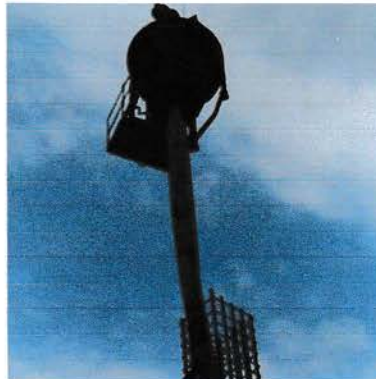
Gambar 4.42 Memasukkan Pipa Termie ke Kolom
