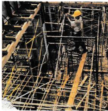
Gambar 4.54 Pemasangan Scaffolding
