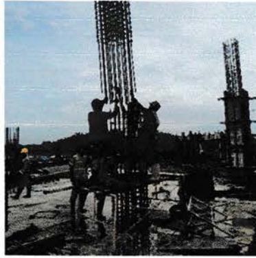
Gambar 4.34 Proses Pemasangan Tulangan Kolom
