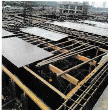
Gambar 4.55 Pemasangan Cetakab Multiplek
