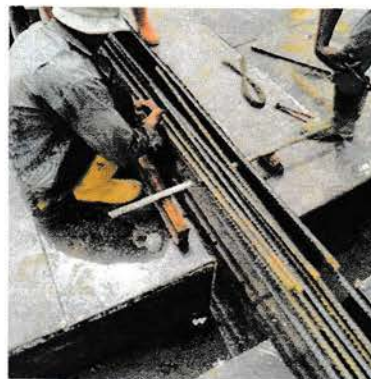
Gambar 4.50 Pemasangan Tulangan Utama
