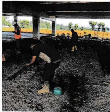
Gambar 4.29 Proses Fabrikasi Tulangan
