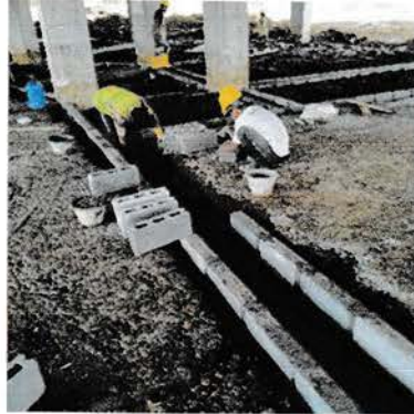
Gambar 4.28 Proses Pemasangan Bekisting
