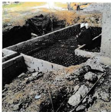
Gambar 4.25 Proses Pengecekan Tulangan
