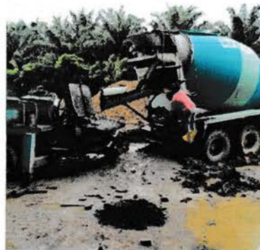
Gambar 4.60 Proses Penuangan Beton
