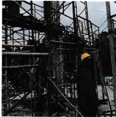
Gambar 4.46 Pemasangan Scaffolding
