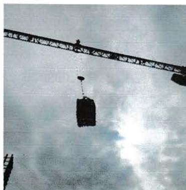
Gambar 4.32 Proses Pemindahan Tulangan
