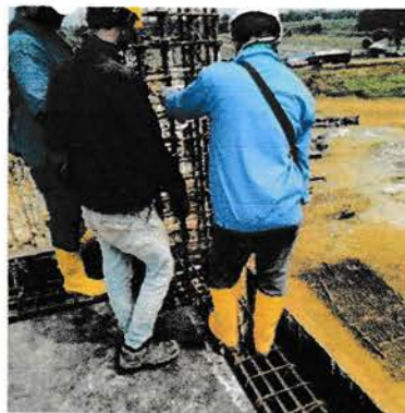
Gambar 4.52 Proses Pengecekan Tulangan
