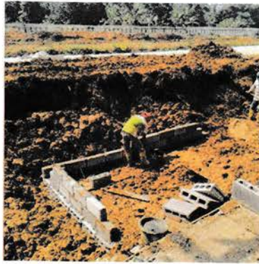
Gambar 4.23 Proses Pemasangan Bekisting Pile Cap
