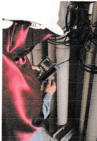
Gambar 4.2 Pengetesan Kabel CCTV
