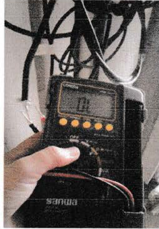
Gambar 4.3 Pengetesan Kabel CCTV
