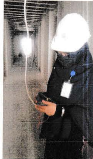
Gambar 4.1 Pengetesan Kabel Speaker
