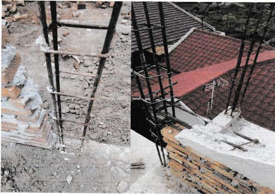
Gambar 5 dan 6 . Pembesian kolom praktis yang telah di letakkan ke bangunan
