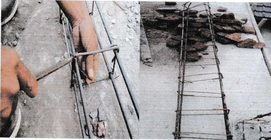
Gambar 3. Pemasangan beugel pada tulangan      Gambar 4. Rakitan besi tulangan
