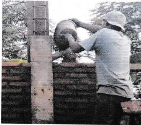
Gambar 9. Pengecoran Kolom
