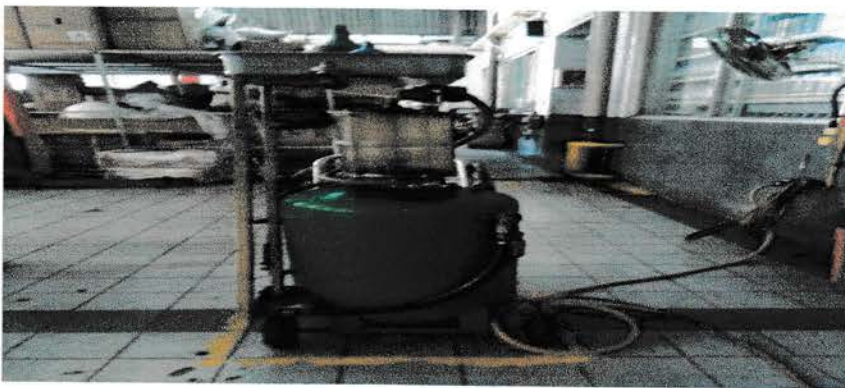
Gambar 3.16. Bak Penampungan Oli.
