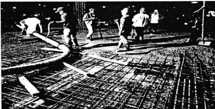
Gambar 3.15 Pengecoran Plat Lantai ( Lapangan )
