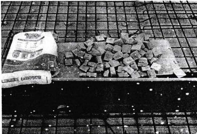
Gambar 3.8 Beton Decking/Tahu Beton ( Lapangan )
