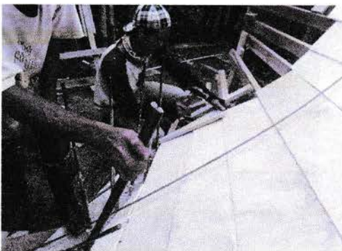
Gambar 27 Proses pemasangan Besi ke bekisting
