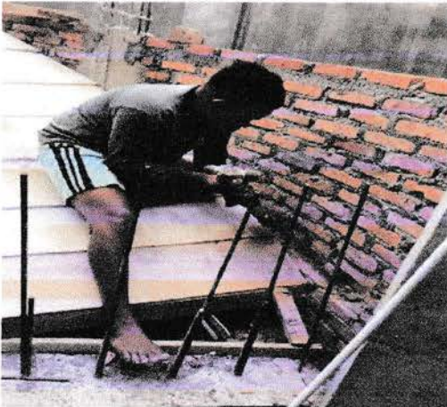
Gambar 25 Proses pembobokan dinding
