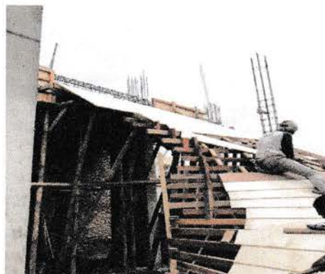
Gambar 22 Proses Pemasangan Bekisting
