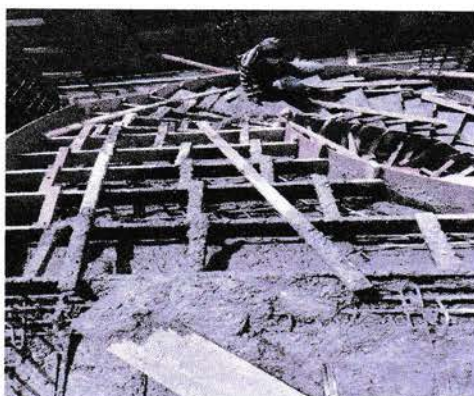
Gambar 32 Tampak tukang sedang meratakan beton
