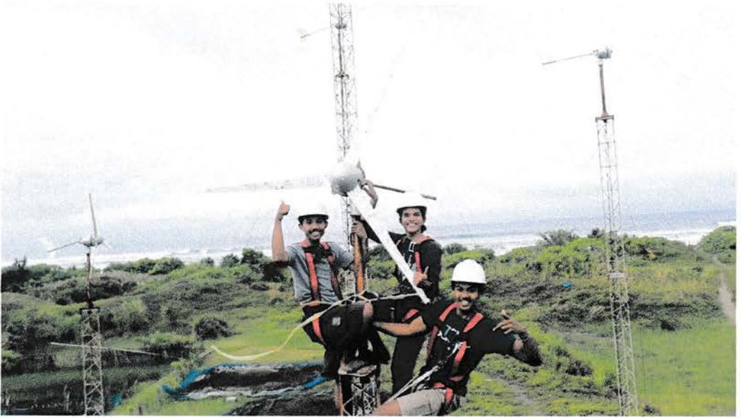
Pemasangan bilah Kincir Angin
