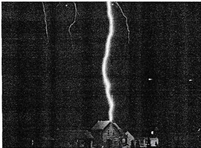
Gambar 3.2(a): Sambaran Petir Mengenai Bangunan (Sumber : https://www.akhmadshare.com/2017/10/jenis-kerusakan-akibat-petir.html )
