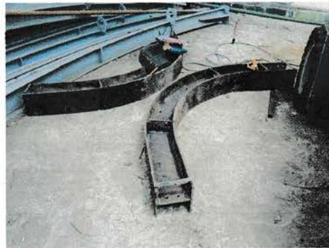
Gambar 3. Proses Pelengkungan H Beam
