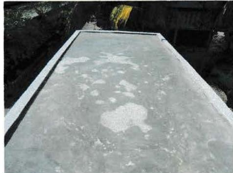
Gambar 19. Finishing atap beton, permukaannya harus halus.
