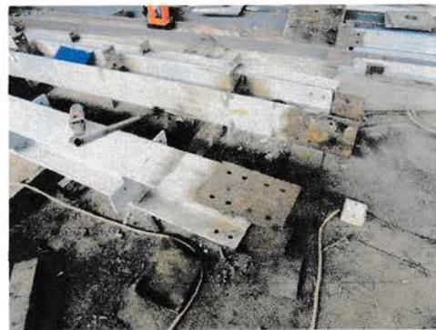
Gambar 1. Pemasangan Plat Penyambung baja WF
