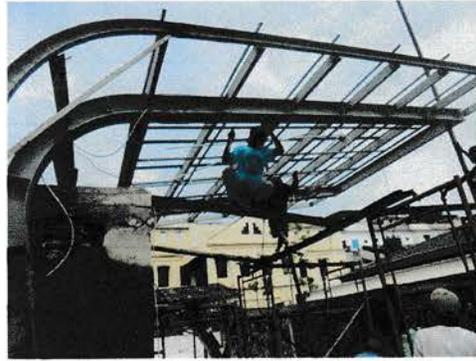
*Gambar 11. Pemasangan Gording untuk kanopi*
