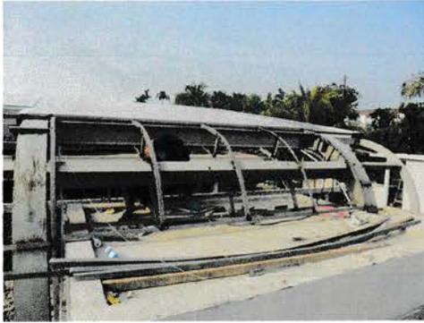
*Gambar 12. Proses Pemasangan Baja UNP*
