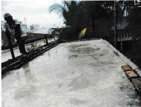
Gambar 20. Proses sebelum di lapisan konkret halus.
