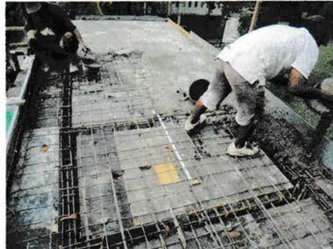
Gambar 15. Proses Pemasangan Pembesian Atap Dak
