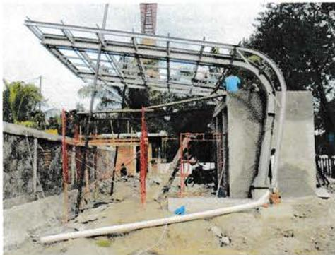
*Gambar 10. Tampak Rangka Atap Kanopi*
