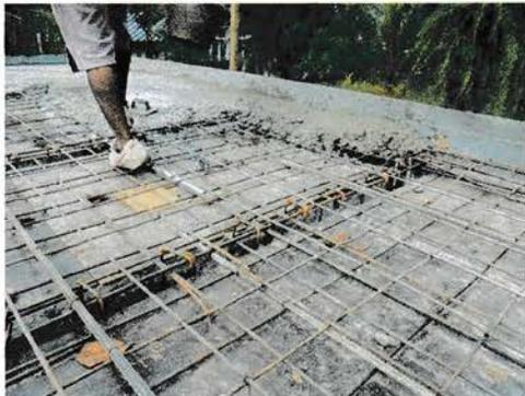
Gambar 14. Instalasi listrik, plumbing dan pembesian siap terpasang.
