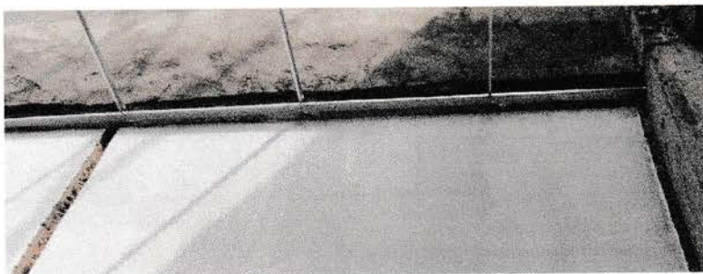
Gambar III.2 Pemasangan wall angle pada dinding.
