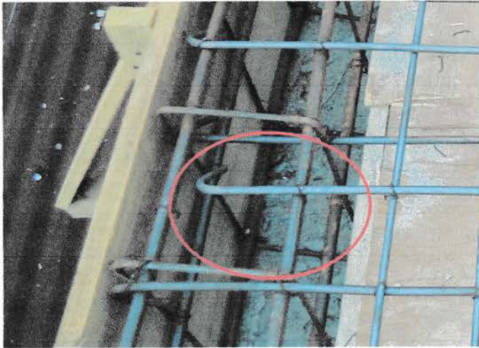
Gambar 6 kesalahan pembesian yang terjadi dilapangan
