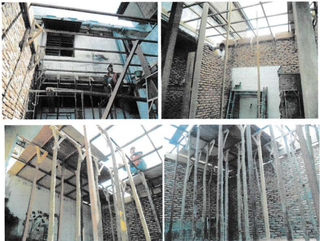
Gambar 3 pemasangan pranca dan triplek
