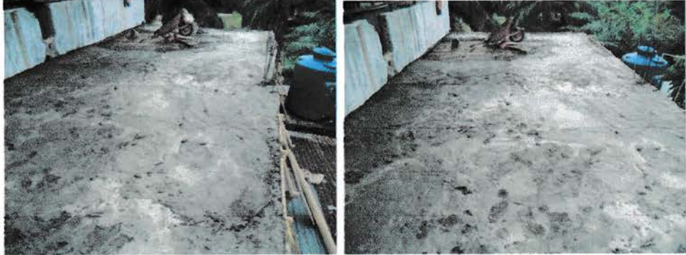
Gambar 5 proses pengecoran Pelat dan balok lantai
