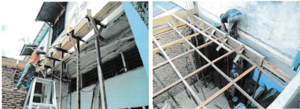
Gambar 1 Pekerjaan Pembuatan Bekisting / Mal Balok
