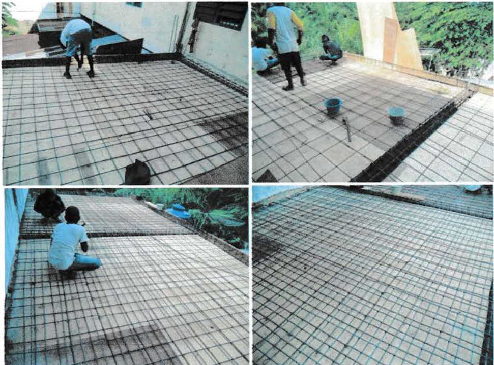
Gambar 4 perakitan besi pelat lantai
