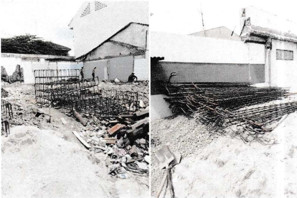
Pada tahap ini dilakukan perakitan Besi Pondasi dan Kolom, seperti terlihat pada gambar diatasgambar diatas kiri adalah rakitan besi untuk pondasi dan yang sebelah kanan adalah besi untuk kolom.
