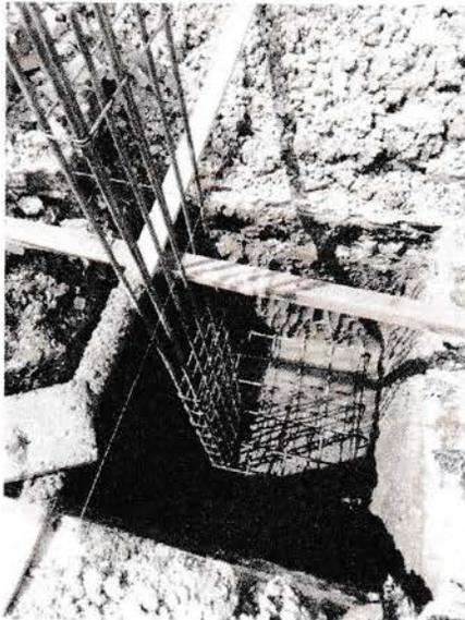
Setelah perakitan besi pondasi dan kolom selesai lalu besi dipasangkan ke dalam lubang yang telah digali bisa dilihat pada gambar diatas.
