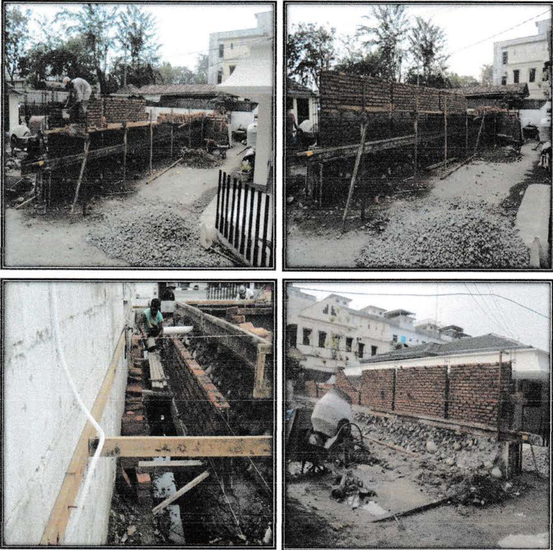
Gambar 1.3. Pengerjaan Pemasangan Batu Bata
