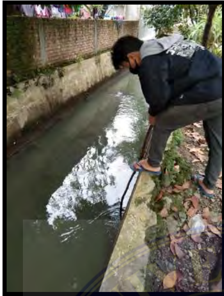
Dokumentasi pengukuran tinggi saluran drainase eksisting pada segmen 6
