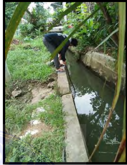
Dokumentasi pengukuran lebar saluran drainase eksisting pada segmen 5
