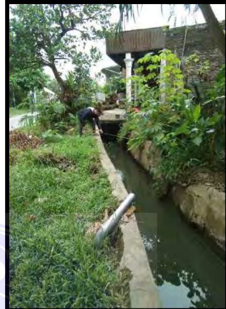
Dokumentasi pengukuran lebar saluran drainase eksisting segmen 2
