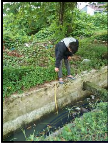
Dokumentasi pengukuran tinggi saluran drainase eksisting segmen 1
