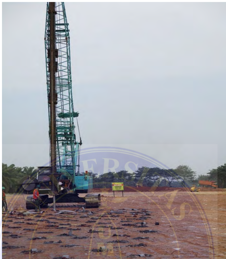
Gambar 2. 9. Posisi pemasangan PVD terhadap mandrel (sumber : Lapangan, 2020)
