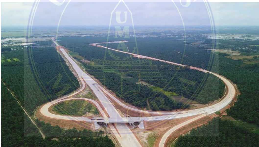
Tampak Jembatan dan Jalan
