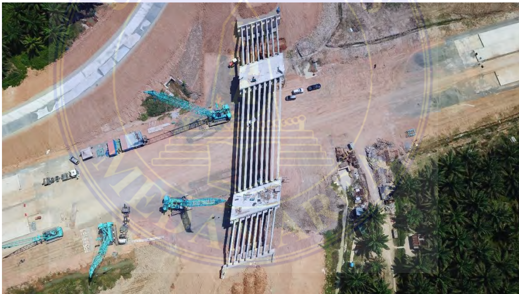
Tampak Atas Jembatan setelah dipasang girder
