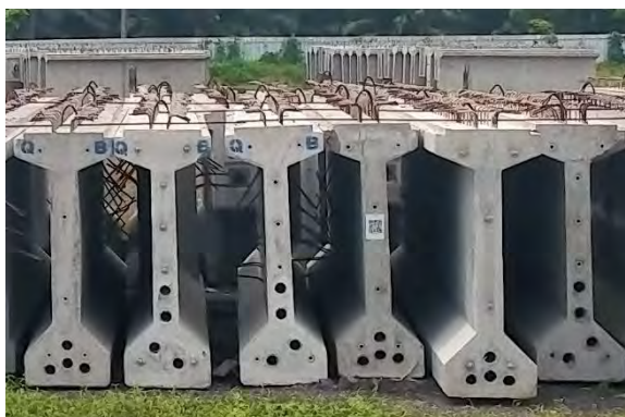
Gambar 2.2 PC I Girder Sumber : Dokumentasi dari lapangan
