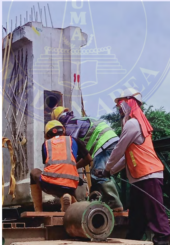
Proses Memasukkan Strand ke Selongsongan Girder
