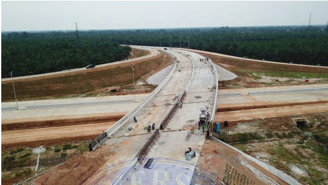
Tampak Jembatan setelah pekerjaan hampir selesai
