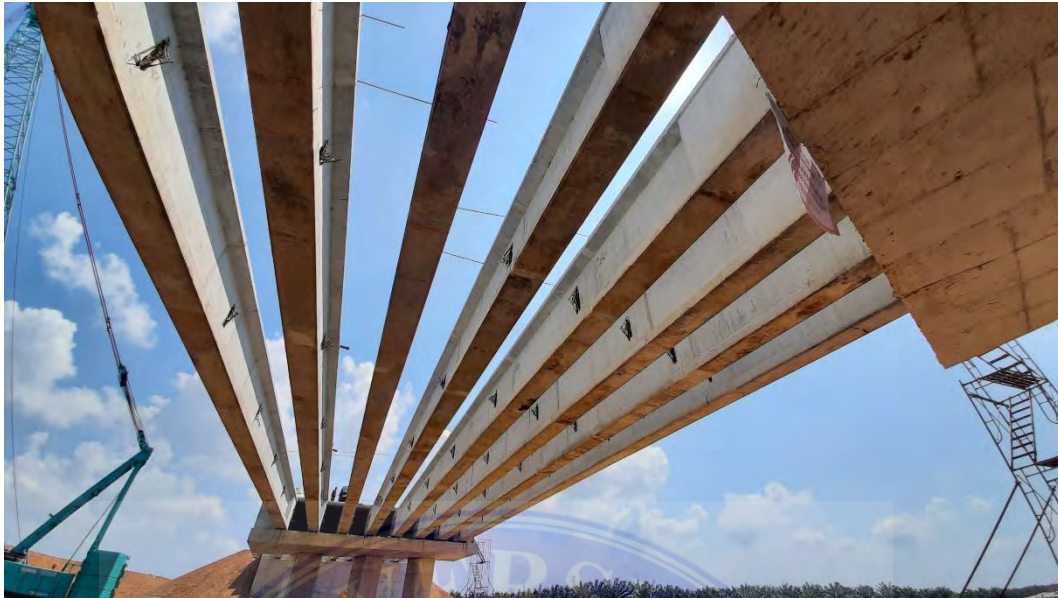
Tampak Keseluruhan Girder setelah dipasang
