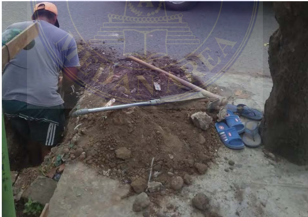
Pemasangan Pipa ke Rumah-Rumah
