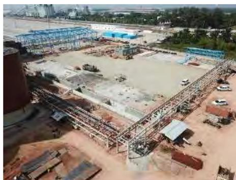
Gambar 1.6 Pekerjaan Pipe Rack
