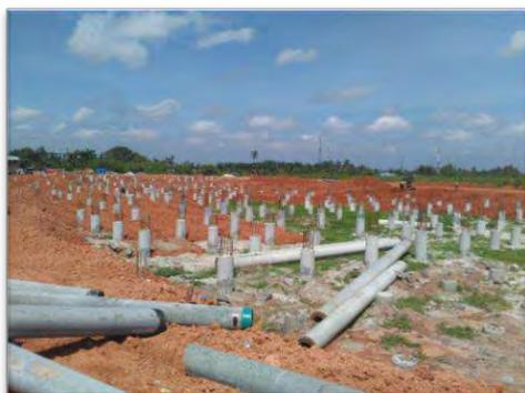
Gambar 1.5 Pekerjaan Pondasi Pancang
