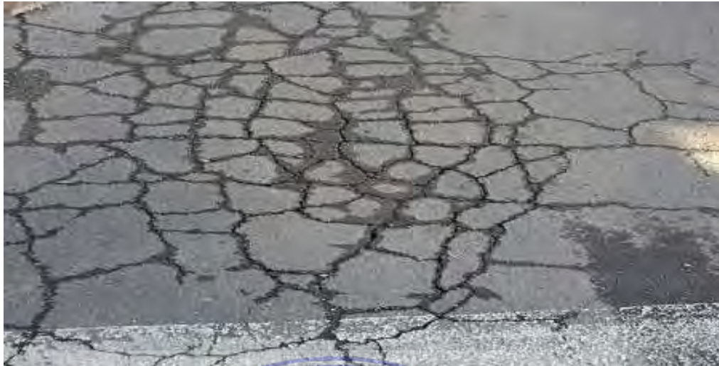
Gambar 2.3.1 Retak kulit buaya
