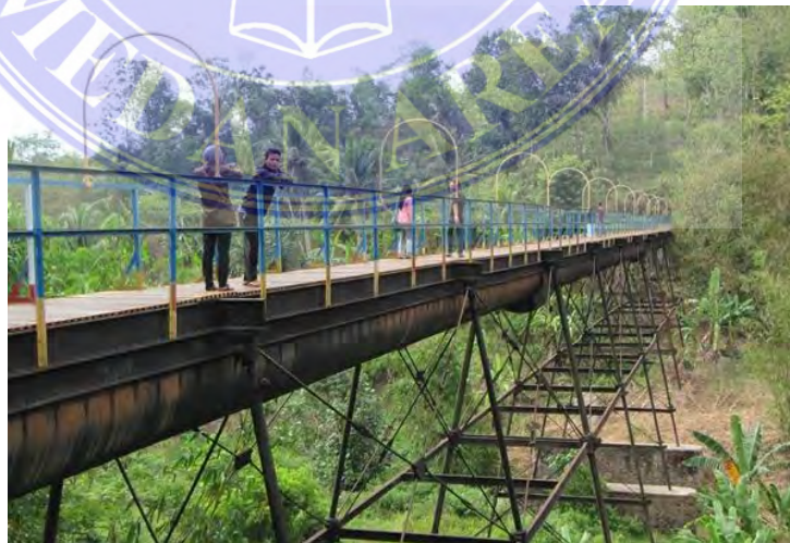
Gambar 2.22 Jembatan talang air Sumber: Wikipedia
