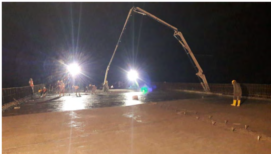
Proses pengecoran pelat lantai jembatan
