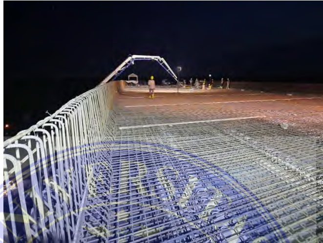
Gambar 2.35 Pelat lantai jembatan sumber : Jalan Tol Tebing Tinggi - Inderapura
