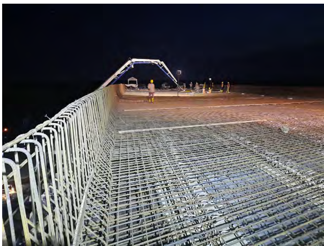
Pelat lantai jembatan dan Barrier yang sudah diberi tulangan
