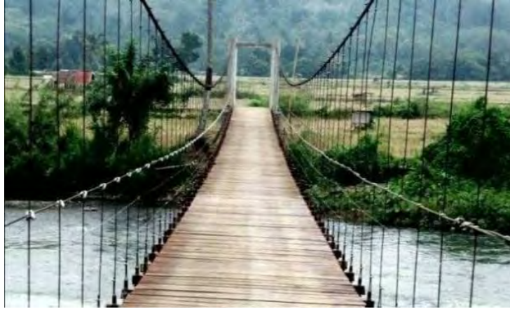
Gambar 2.26 Jembatan gantung Sumber: pu.go.id
