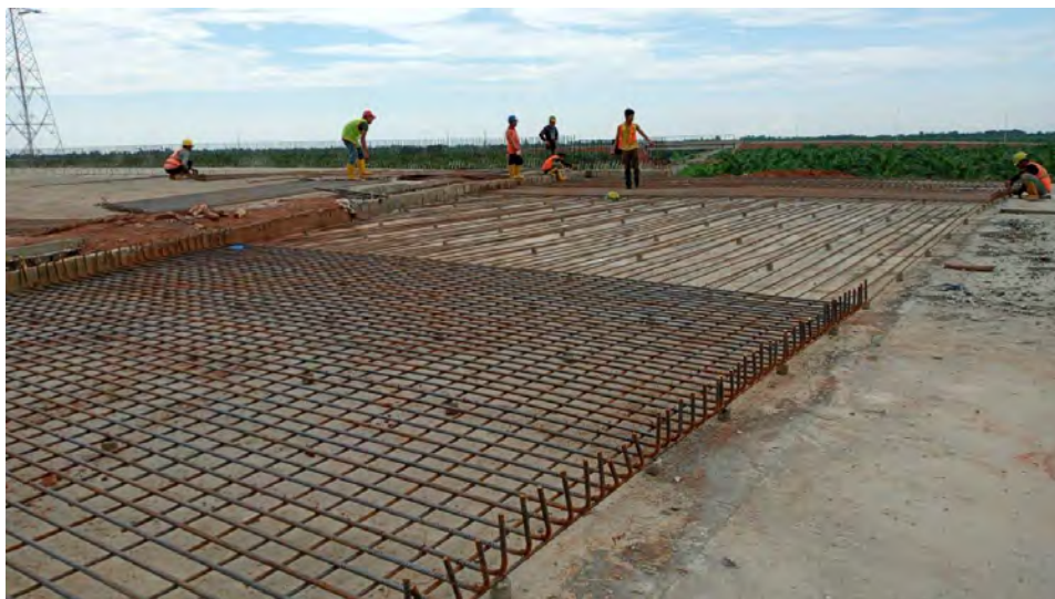
Perakitan tulangan pada pelat jembatan
