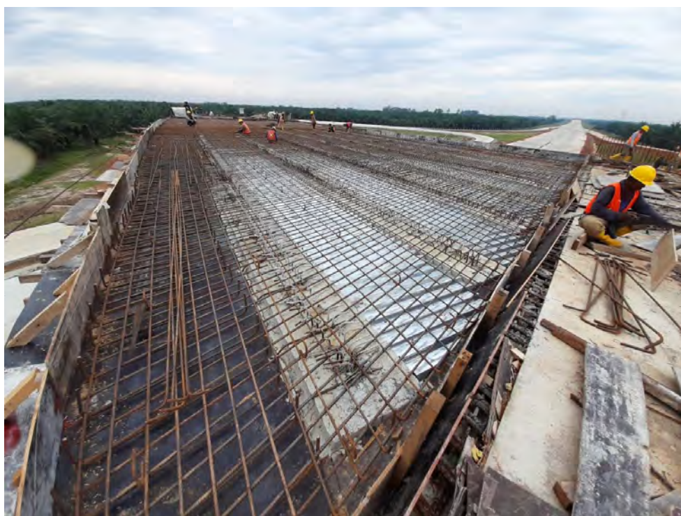
Setelah dipasang tulangan pada pelat jembatan
