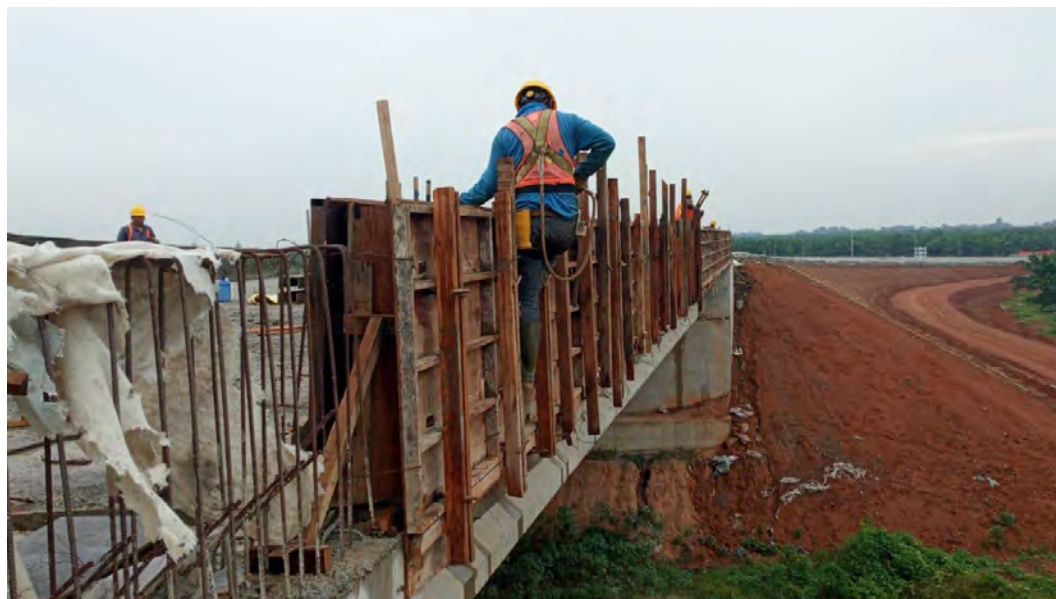
Pemasangan bekisting barrier dan tulangan barrier
