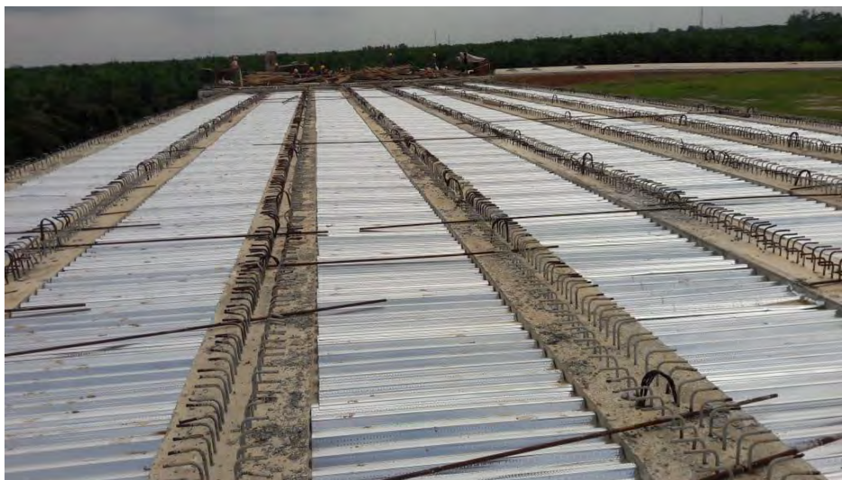
Setelah dipasang Floor deck /Pelat Bondek
