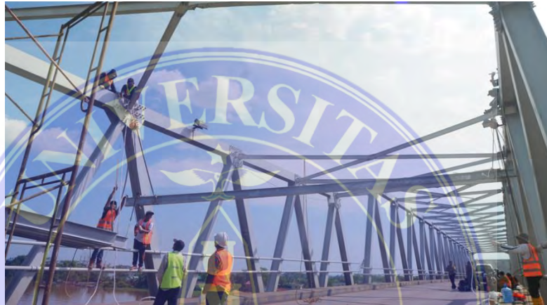
Gambar 2.5 Ikatan pengaku (angin) jembatan Sumber: Pontianakpost.co.id
