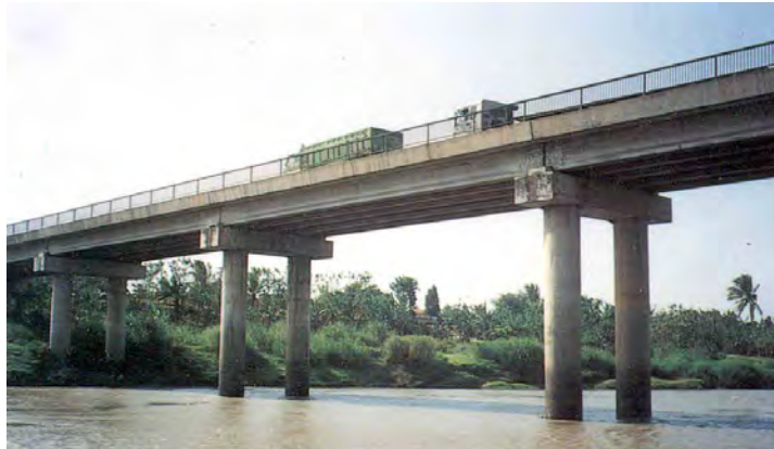
Gambar 2.13 Jembatan beton bertulang balok T Sumber: Jembatan (2007)
