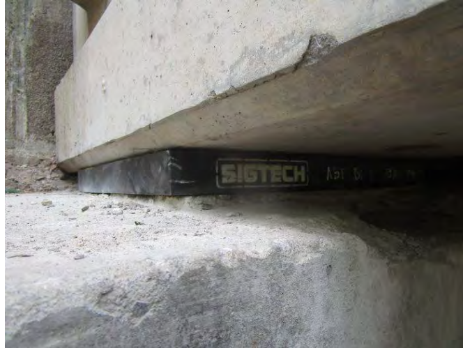
Gambar 2.6 Tumpuan jembatan Sumber: Jalan Tol Tebing Tinggi – Inderapura
