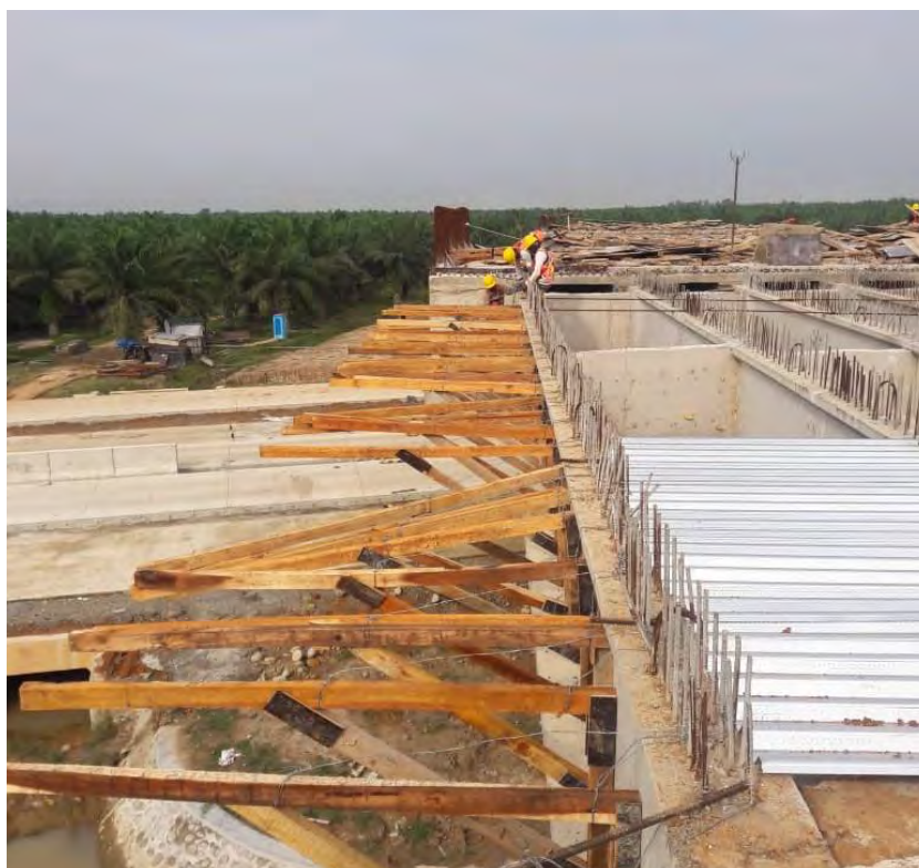
Proses pemasangan floor deck /pelat bondek dan bekisting kantiveler
