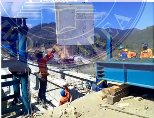
Gambar 2.4 Gelagar melintang/Diafragma Sumber: Jurnal Teknik Sipil
