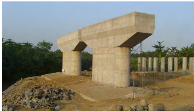
Gambar 2.10 Pilar jembatan Sumber: Sarjanasipil.my.id
