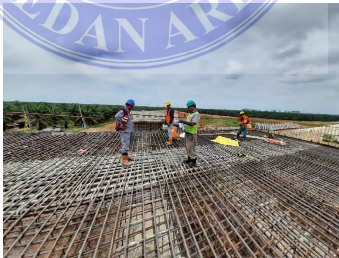
Gambar 2.7 Pelat injak jembatan Sumber: Jalan Tol Tebing Tinggi - Inderapura
