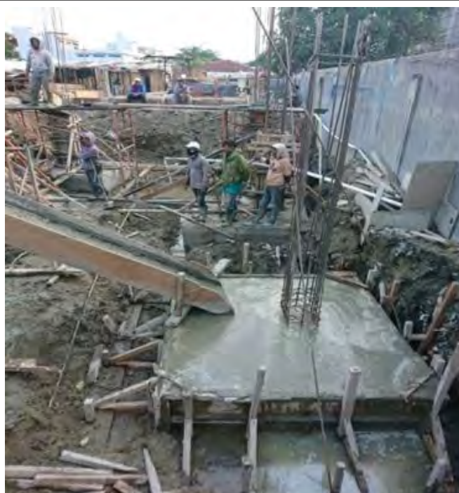
Pengecoran pondasi telapak RS.Wulan Windi
