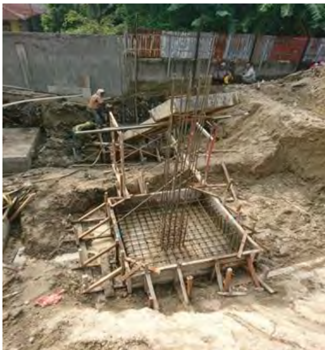
Pemasangan bekisting pondasi sebelum pengecoran
