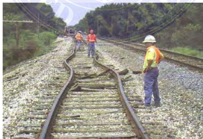
Gambar 2.8 Gerakan ular ( snake motion ) pada jalan rel
