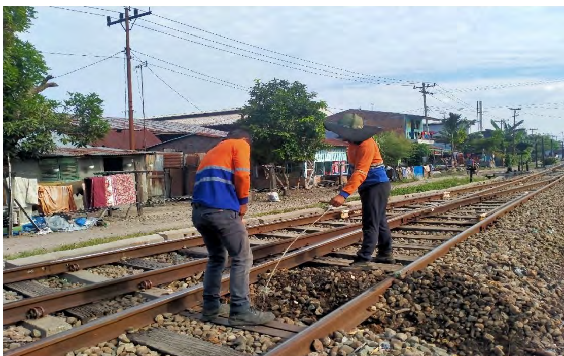
Gambar: Proses pemasukan bantalan baru dan Pengukuran lebar sepur
