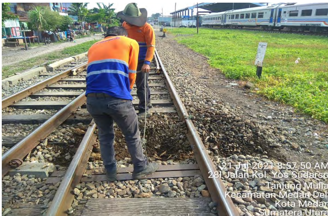
Gambar: menggorek balas sekitar bantalan
