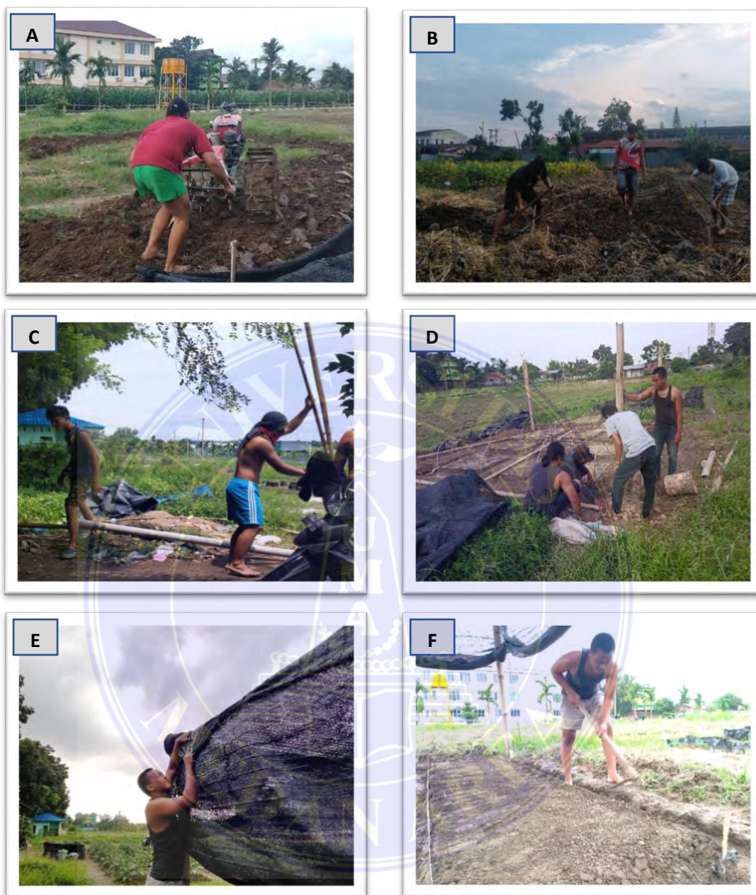
Gambar 1. Persiapan lahan dan pembuatan naungan. Keterangan: A. Pembukaan lahan, B. Perataan lahan, C. Persiapan bambu, D. Pemasangan tiang naungan, E. Pemasangan paranet 70%. F. Pembuatan bedengan dan drainase.
