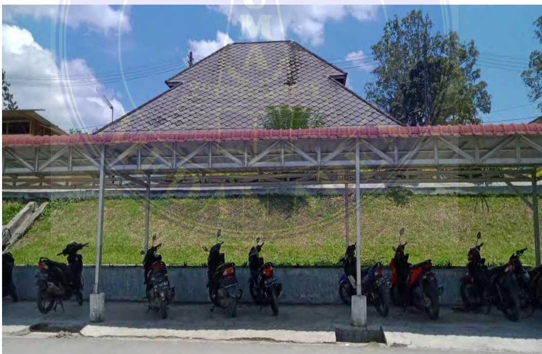
Parkir motor yang terletak di depan ruang rawat inap Dahlia, terdapat pula parkir motor di setiap ruang rawat pasien dan parkir mobil yang terletak di samping ruang IGD
