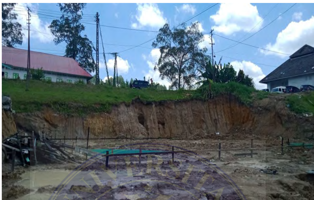
Proses pembangunan ruang Instalasi Gizi untuk makanan pasien RSUD Tarutung
