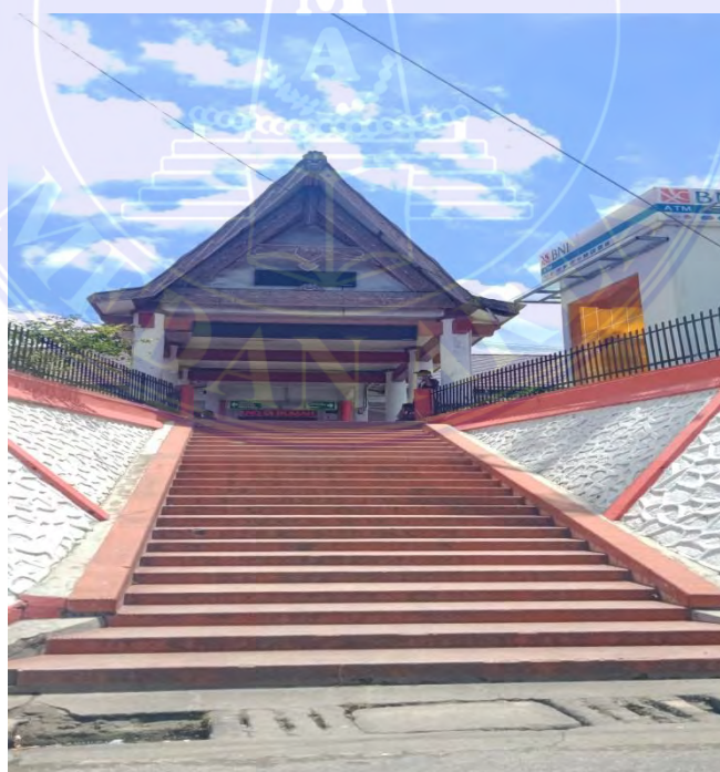
Pintu masuk pengunjung RSUD Tarutung
