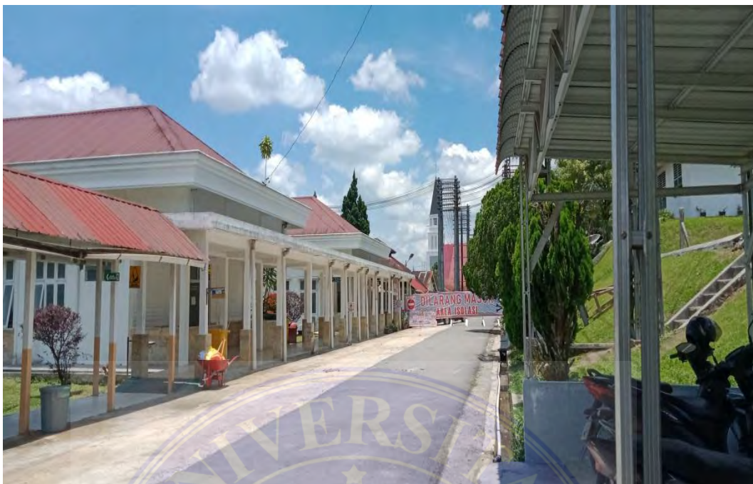
Lokasi area isolasi/ruang rawat pasien Covid-19 berada di ujung ruang rawat inap yang diberi tanda dengan menggunakan spanduk “Dilarang Masuk”
