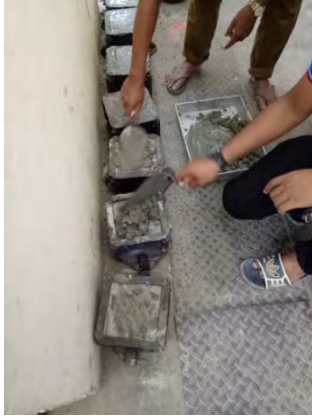
Memasukkan Campuran Ke Cetakan
