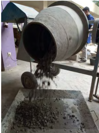
Campuran Siap di Uji
