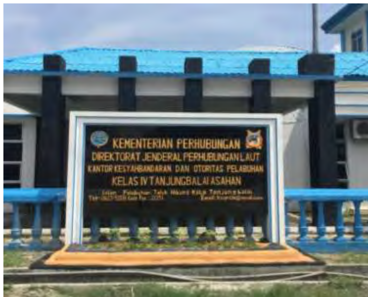
Gambar 1 : Keadaan Kantor Kesyahbandaran dan Otoritas Pelabuhan Kelas IV Tanjungbalai Asahan (Sumber: Dokumentasi Pribadi, Rabu 3 Februari 2021)
