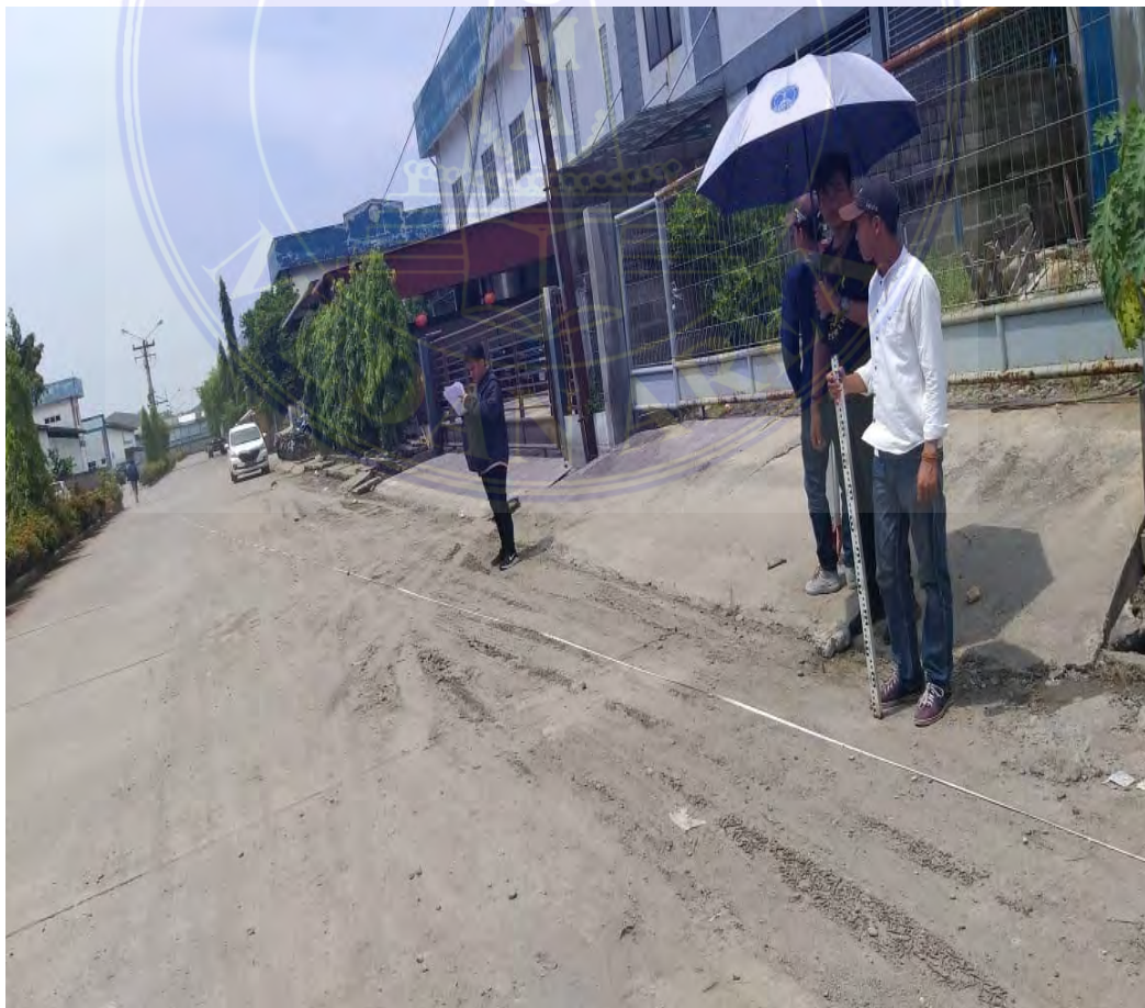
Gambar Pengukuran di Lapangan
