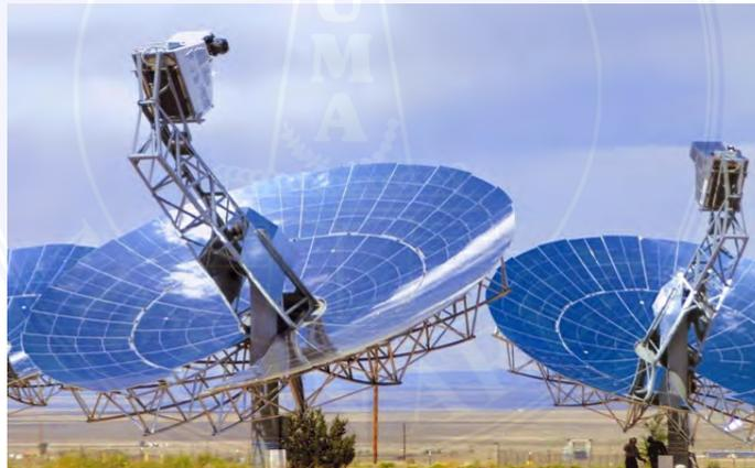
Gambar 2.2.1a. Pembangkit tenaga Surya Berbentuk Parabola, ([www.solarthermalmagazine.com](http://www.solarthermalmagazine.com))
