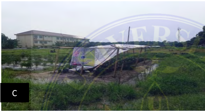
Gambar 7. C. Salah satu masalah apabila hujan dan badai datang di tengah malam. Dan keadaan ini tidak terkontrol dimana tiang penyangga roboh dan tidak dapat menahan tekanan.
