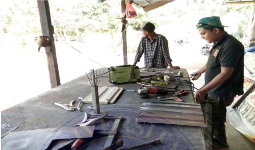
Proses pembuatan cetakan genteng beton
