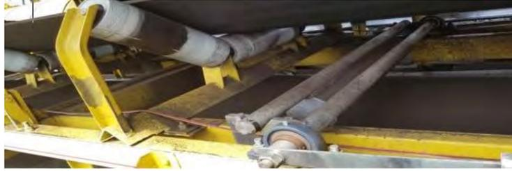
Gambar 2.4. Kerangka belt conveyor yang digunakan di PLTU Pangkalan
