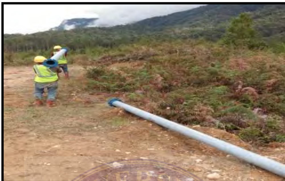
Pekerjaan Pikul Pipa dari Direksikeet ke Lokasi
