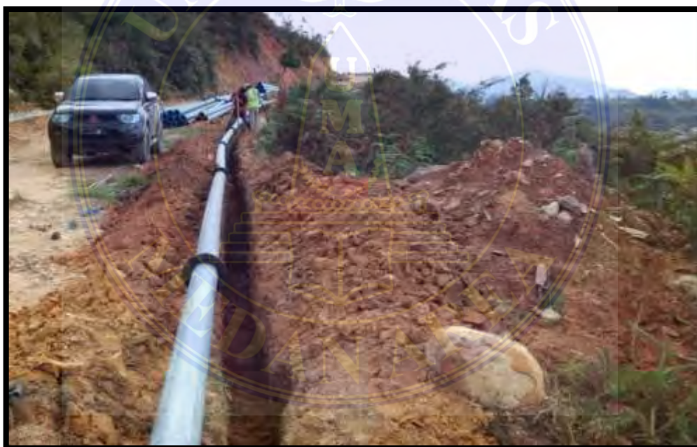
Pekerjaan Pemasangan Pipa GIP Ø150 mm
