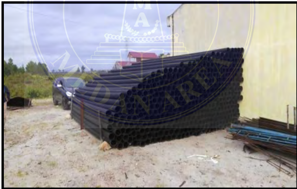
Pekerjaan pengadaan pipa HDPE Ø 150 mm Pn-10 Sdr-17
