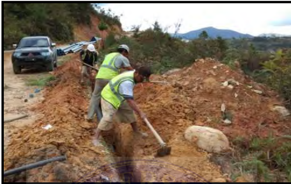
Pekerjaan Timbunan Tanah Kembali dan Pematatan
