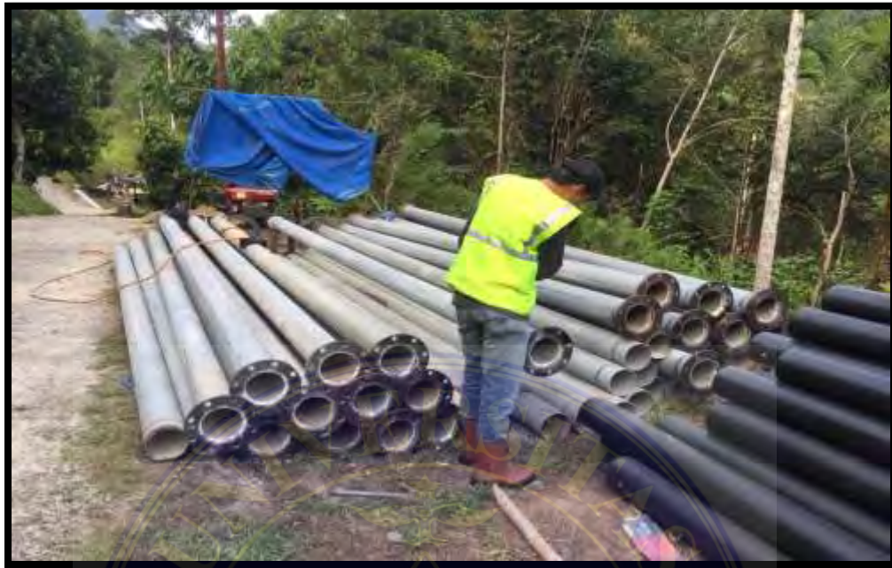
Pekerjaan pengadaan pipa GIP Ø 150 mm
