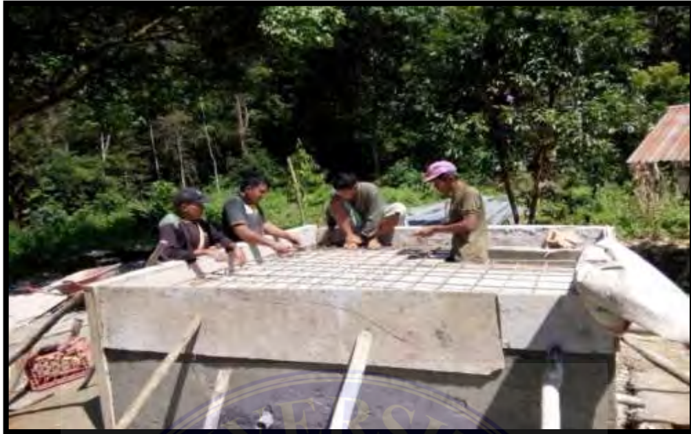
Pekerjaan Reservoir Marpadan
