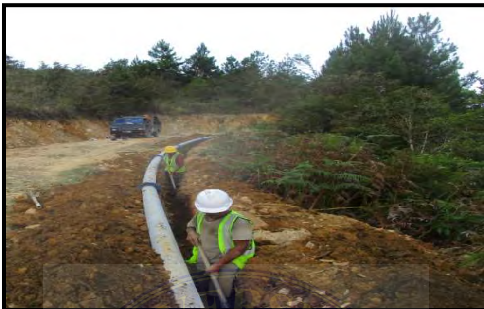
Pekerjaan Galian Tanah berbatu Kedalaman 0-1 m'
