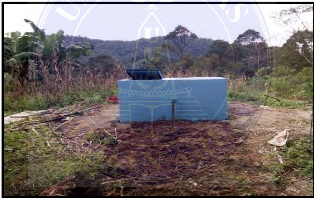
Pekerjaan Reservoir Marpadan
