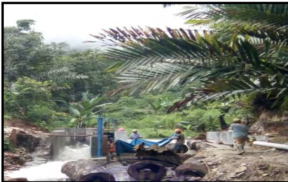
Pekerjaan Bangunan Intake
