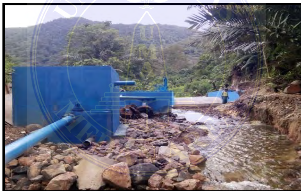
Pekerjaan Bangunan Intake
