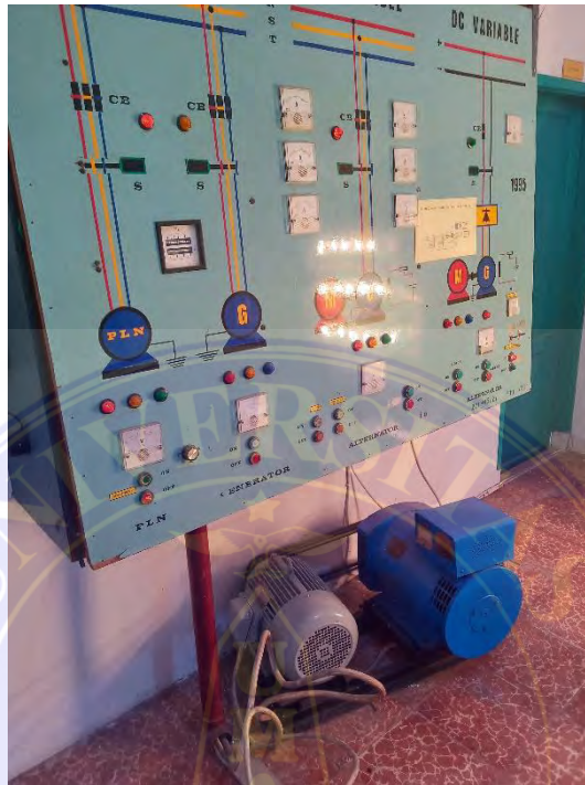
Gambar panel kontrol generator motor laboratorium Teknik Elektro UMA.
