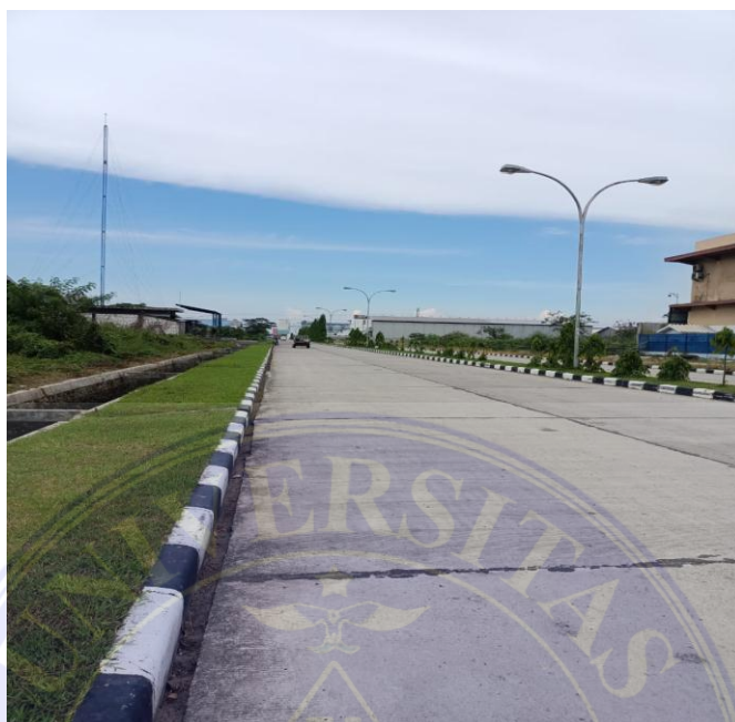
Sumber: Survey Langsung
