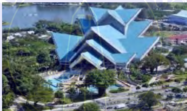
Gambar 2.4.1.2 Bentuk Bangunan National Theatre Malaysia
