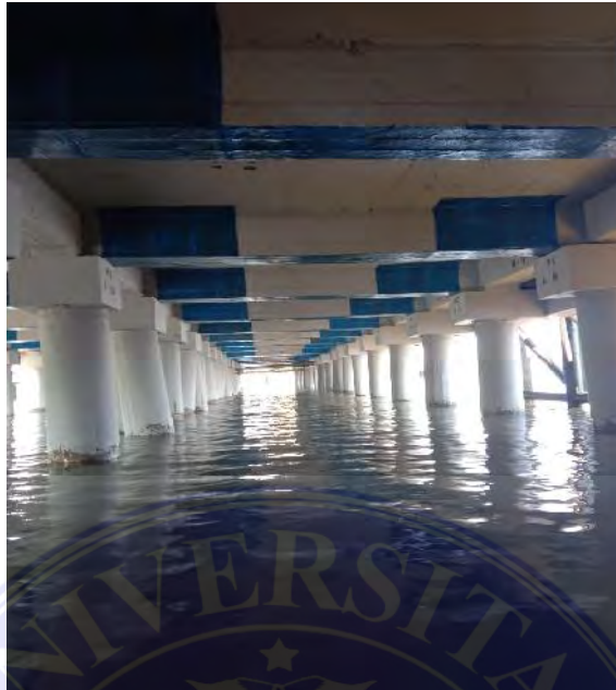
Gambar 2.14 Balok Dermaga Sumber: Dokumentasi lapangan
