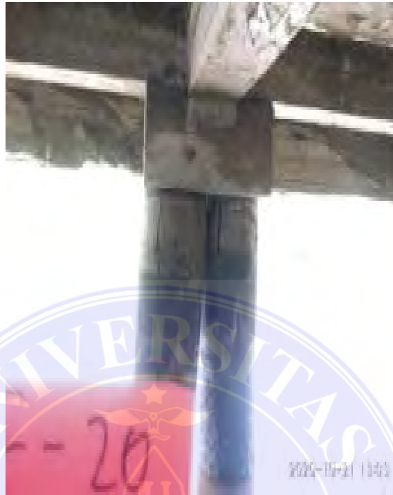
Gambar 2.16 Pondasi Tiang Sumber dokumentasi lapangan
