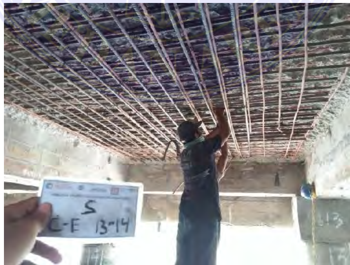
Gambar 2.15 Pelat Lantai Dermaga Sumber: Dokumentasi lapangan
