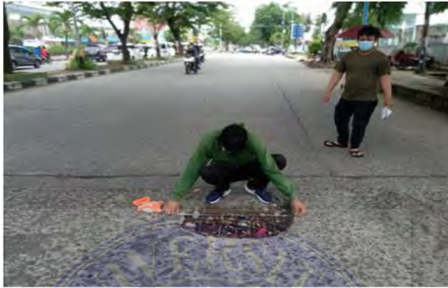
Pengukuran Kerusakan Jalan ( Lubang)
