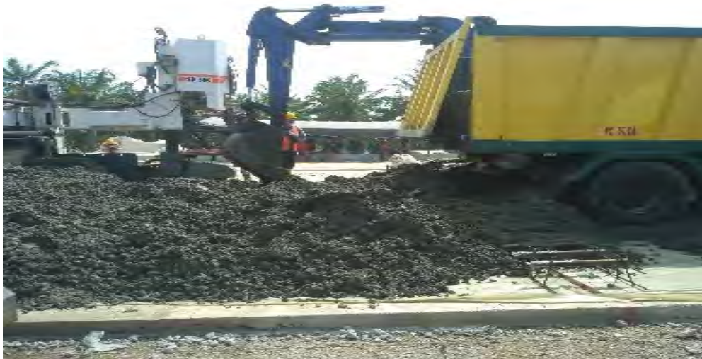
Gambar 2 : Alat Berat Dari Excavator dan Dumptruck .
