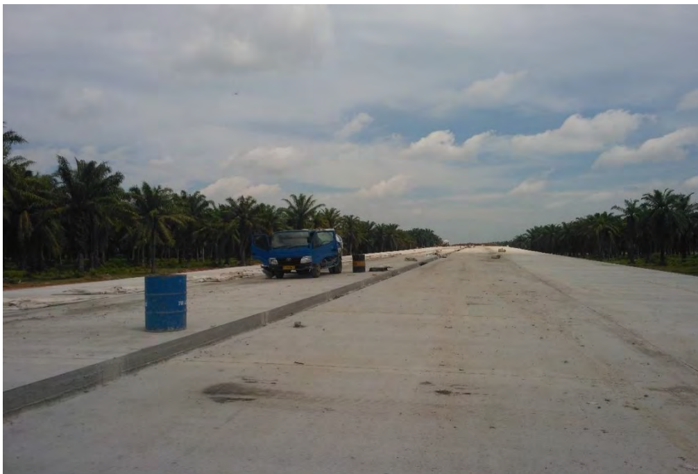
Gambar 9 : Perkerasana kaku ( Rigid Pavement ) yang sudah kering
