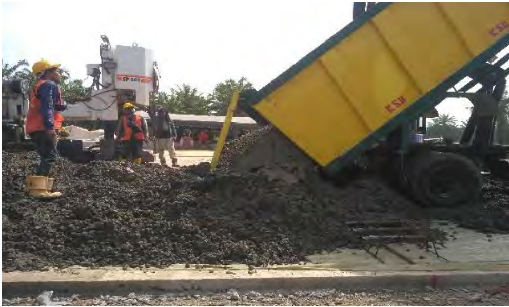
Gambar 3 : Material Untuk Membuat Rigid
