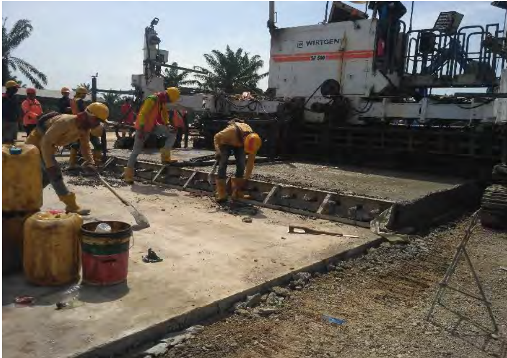
Gambar 5 : Memasukan Dowel Setelah Proses Rigid
