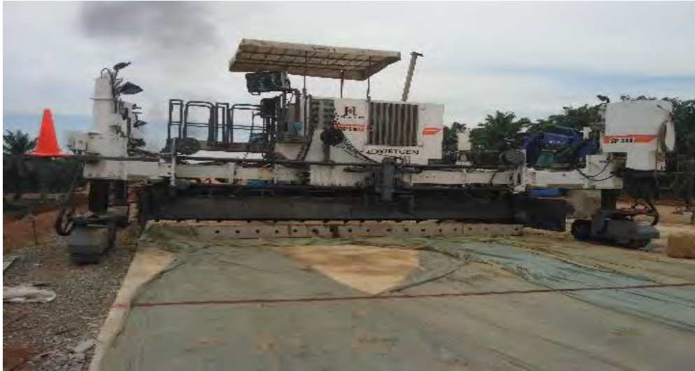
Gambar 1 : Alat Berat Wirtgen untuk membentuk perkerasan Rigid
