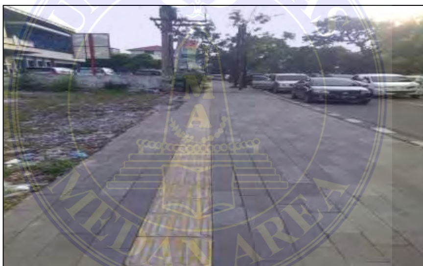
Gambar 3.12 Kondisi Eksisting Trotoar Jalan Sumber : Hasil Dokumentasi Survey, 2019
